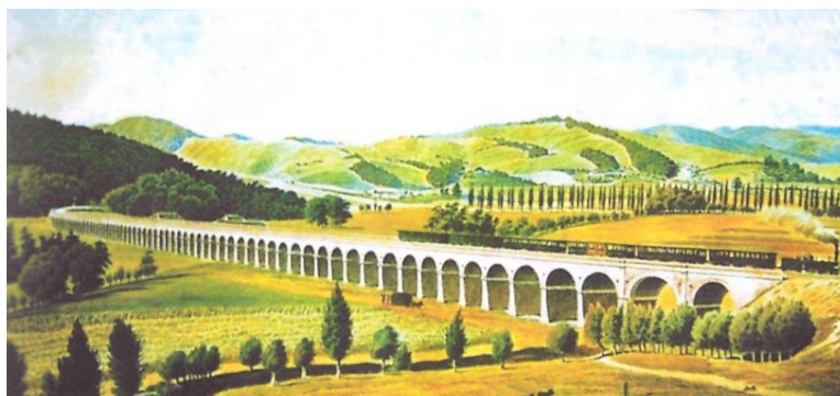
Slika 2: Pesniški viadukt. (Košir, M. in Bogić, M, 2013)
