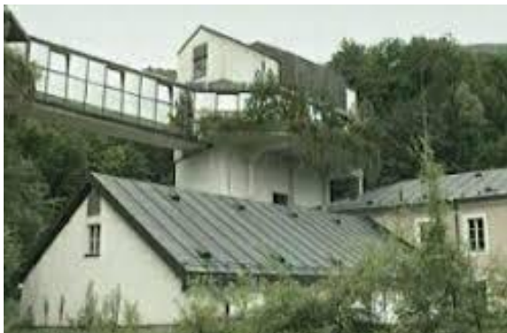
Slika 9: Rimske terme pred obnovitvijo 4
