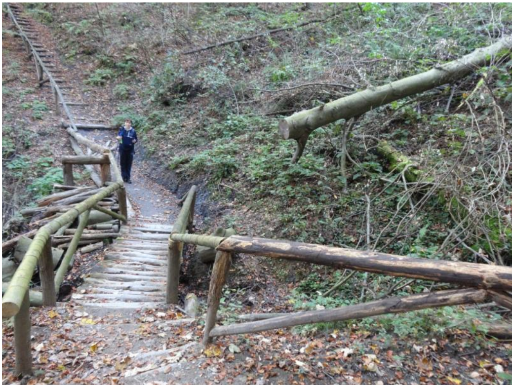
Fotografija 9: Podrta bukev in popravljen most na točki 4, oktobra 2014
