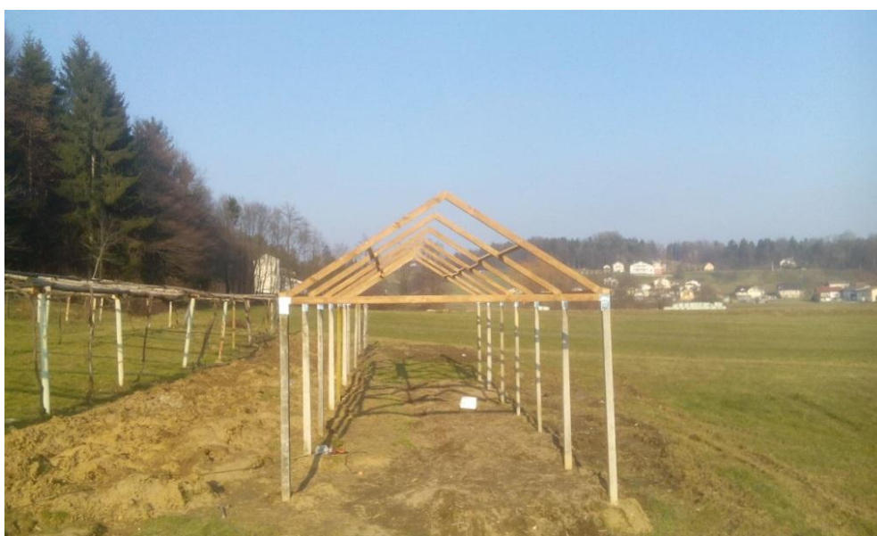
Slika 3: Rastlinjak v izgradnji
