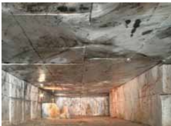
Slika 17: Kamnolom Hotavlje – podzemni kop
