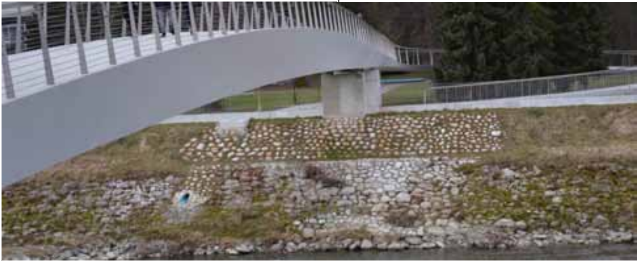
Slika 25: Obložena brežina pri novem mostu v Celju
