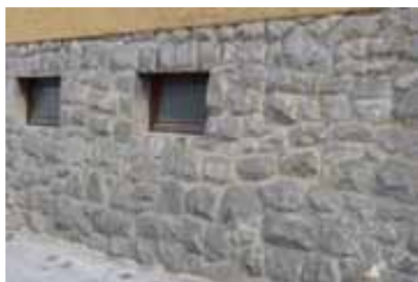
Slika 20: Kamen kot obloga cokla fasade
