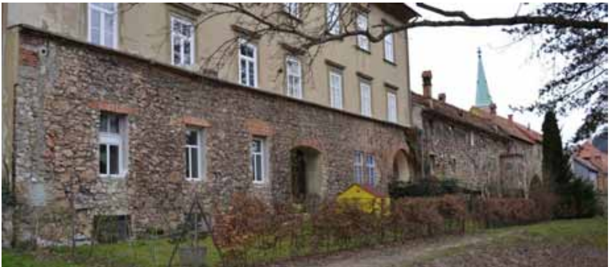
Slika 31: Kamnito pritličje stare celjske hiše
