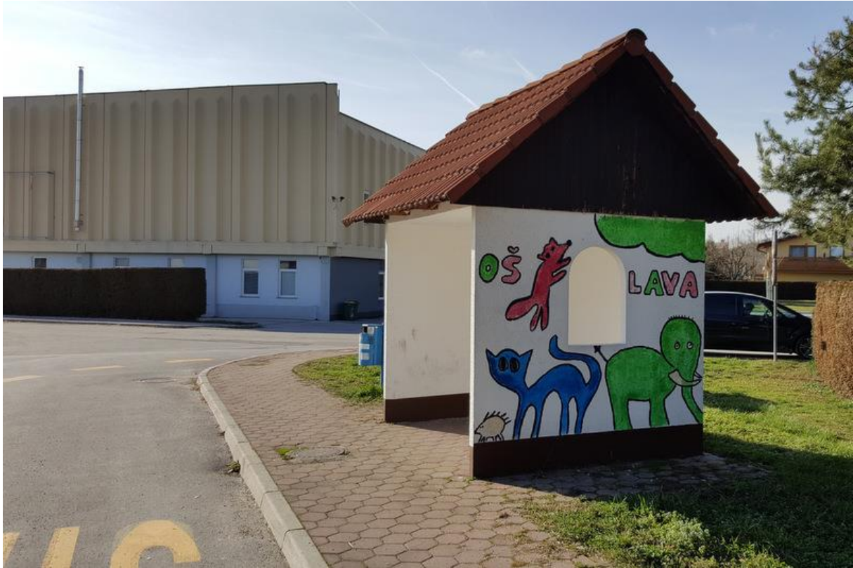
Slika 5 majhno nepregledno okno na zidanem postajališču
