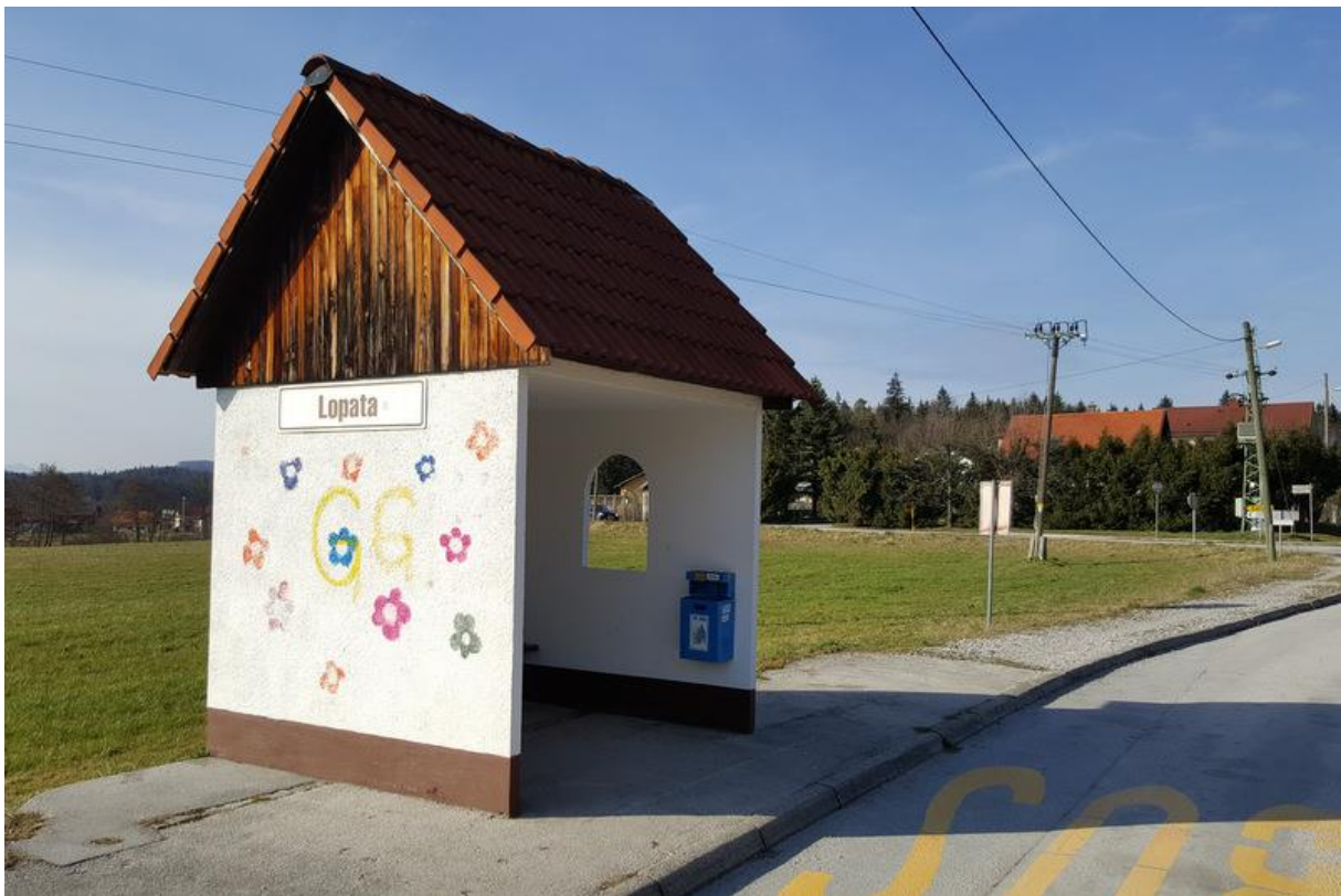
Slika 4 zidano avtobusno postajališče
