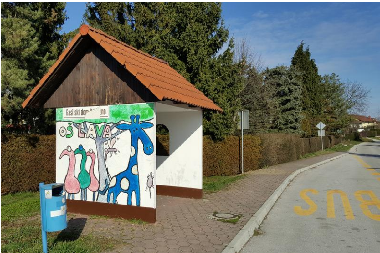
Slika 5 zidano avtobusno postajališče
