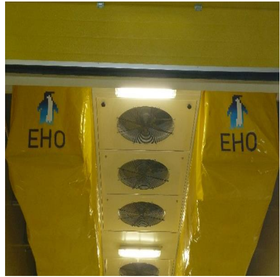
Slika 20: Tesnilne vreče in ventilatorji (Foto: Koren, 2015)
