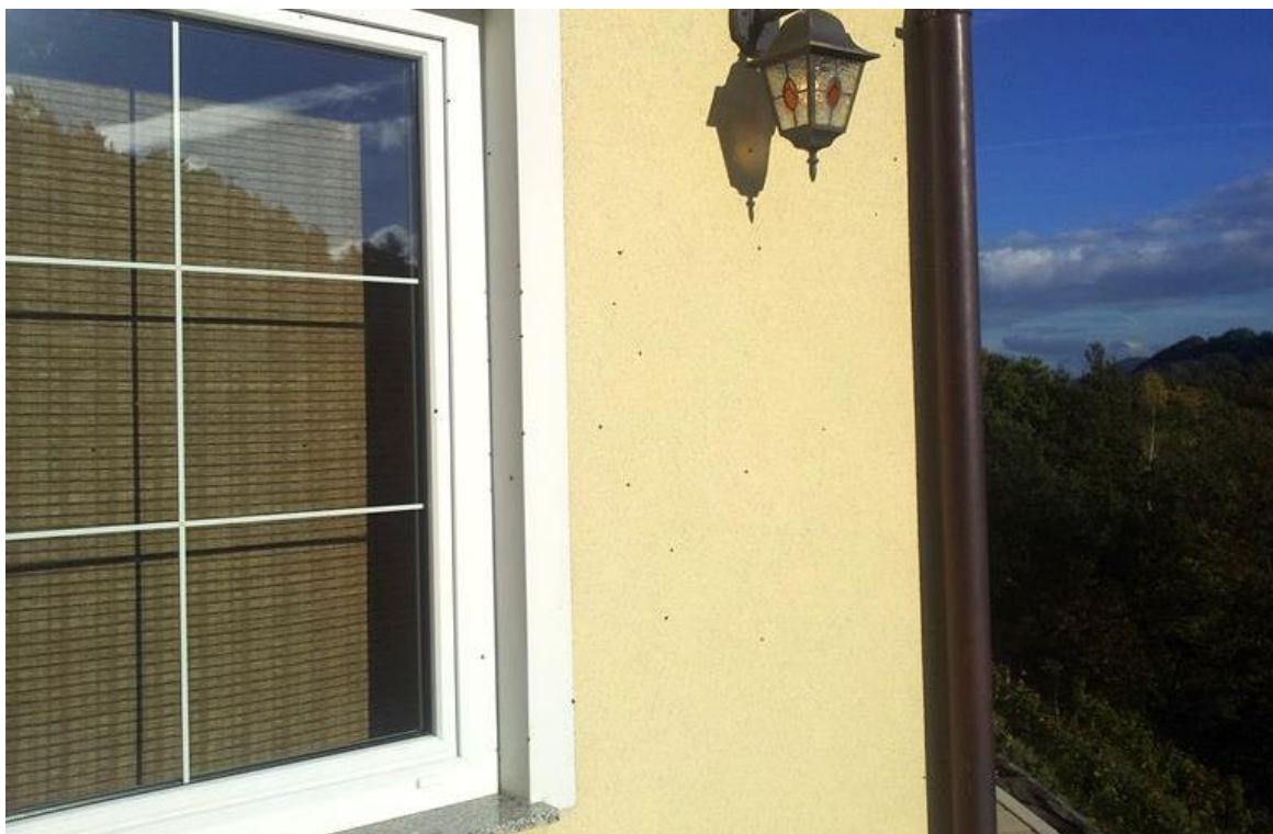
Slika 1: Pisane polonice na fasadi hiše (Foto: Lara Vozlič, 17. 10. 2015)
