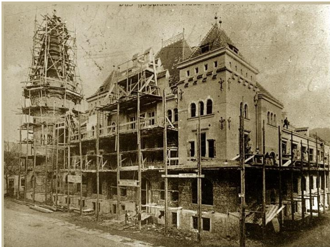
Slika 36: Gradnja Nemške hiše (Vir: www.kamra.si , 7. 3. 2016)
