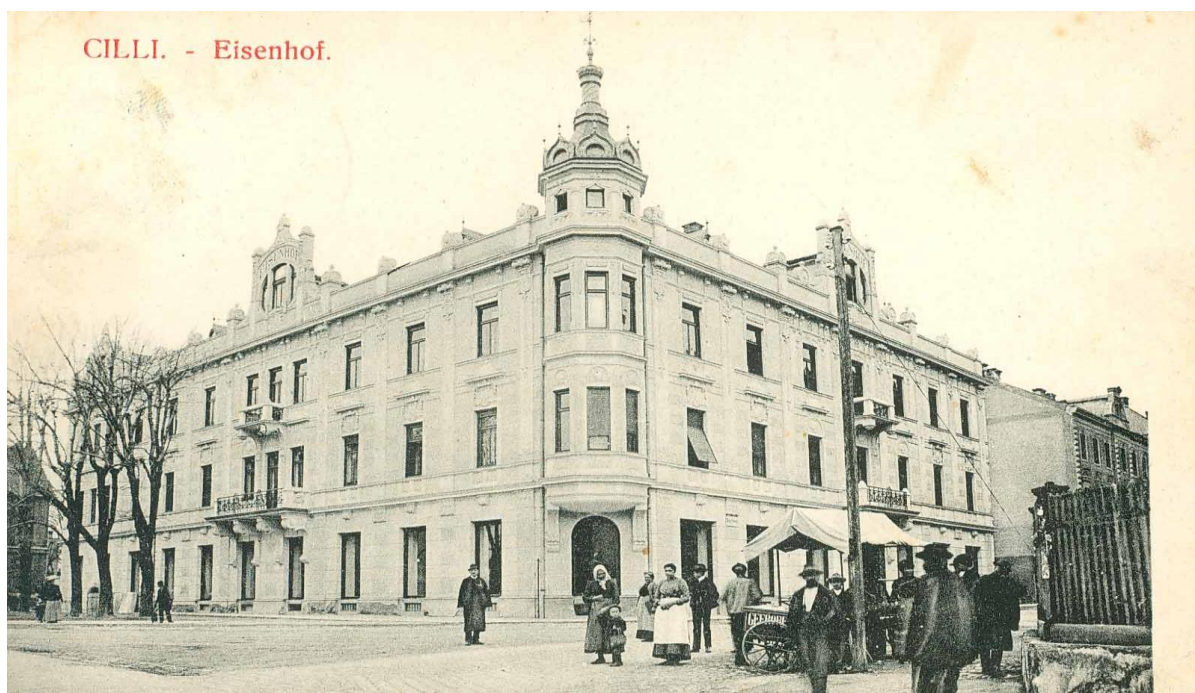
Slika 27: Železni dvor pred 1. svetovno vojno (Vir: ZAC)
