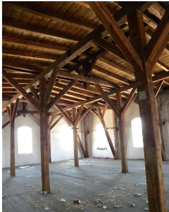
Slika 24: Sistem opornikov v četrtem nadstropju leta 2012 (Vir: arhiv ZVKD)
