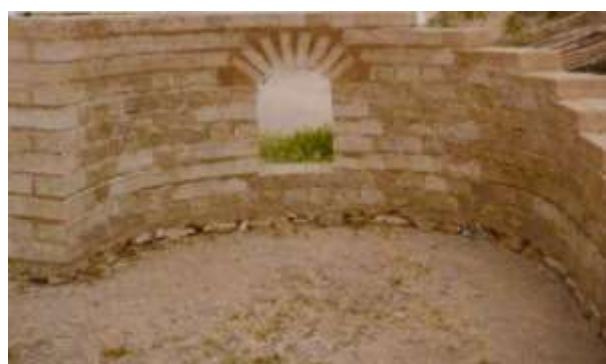
Slika 38: Zid iz zidakov narejenih iz konopljinega betona (Vir 1)
