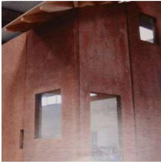
Slika 42: Paneli iz konopljinega betona (Vir 1)
