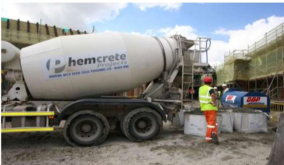
Slika 54: Vgrajevanje konopljinega betona s pomočjo strojev (Vir 21)
