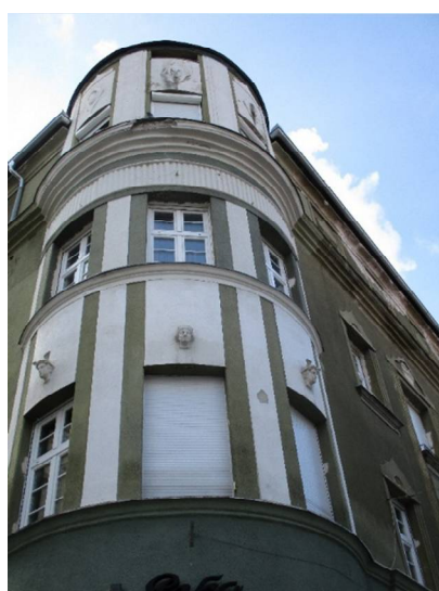
42. Vogalni pilaster zgradbe nekdanje Jadranske banke s figurami krilatih Hermesov in reliefnim prikazom dejavnosti ter emblemom JB (Jadranska banka) nad vhodom
