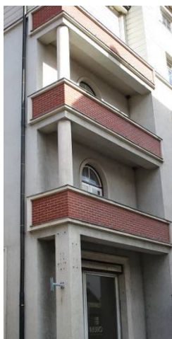
105. V zgradbo pomaknjeni balkoni z rozetnimi okni nad galerijo Plevnik-Kronkowska na križišču Razlagove in Pleteršnikove ulice.
