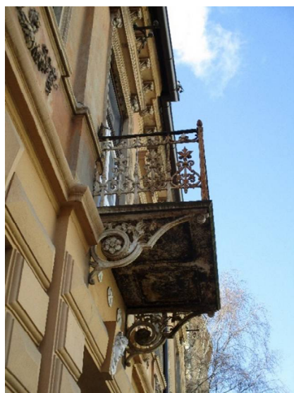
106. Kovinski balkon na zgradbi v Mikolšičevi ulici. "... kjer stopajo urbanizem, obrt in arhitektura z roko v roki." (Janko Hartman)
