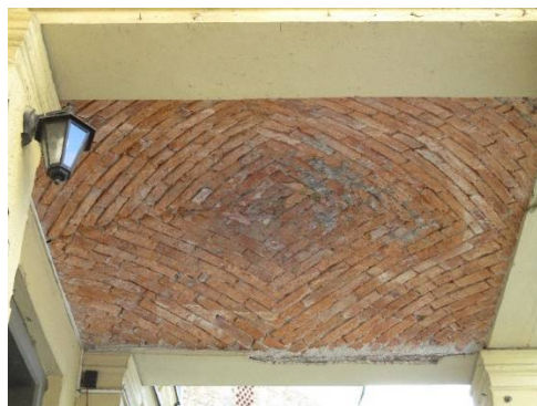
107. Z opekami "velban" star strop balkona na meščanski hiši v Vodnikovi ulici 20
