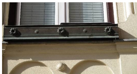
77. Drobno kovinsko okrasje okenske police poudarja celotni videz meščanske zgradbe na Gubčevi ulici.
