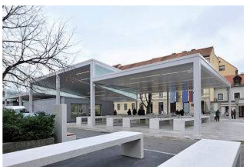
68. Mestna tržnica (Ark Arhitektura Krušec, 2009). Dolgo časa je bil v Celju glavni tržni prostor na Glavnem trgu, v 50. letih preteklega stoletja pa so tržno mesto preselili v Linhartovo ulico.
