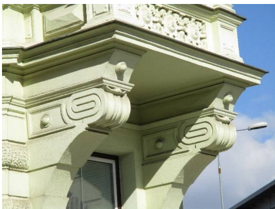
93. Nosilna konzola balkona na vogalu Cankarjeve in Aškerčeve ulice
