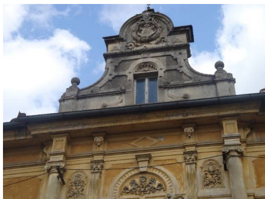
95. Monumentalen zaključek pročelja zgradbe na Razlagovi ulici 7 zaradi denacionalizacijskih postopkov še čaka na obnovo.
