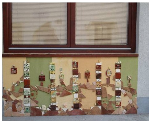
97. Okrašena fasada na zgradbi Jane Kvas v Umetniški četrti na dvorišču galerije Nika Ignjatiča na Gosposki ulici.
