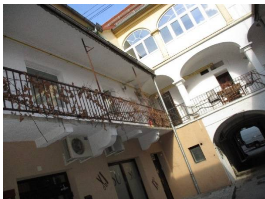
98. Skupni balkonski vhodi v stanovanja na urejenem notranjem dvorišču na Gosposki 7
