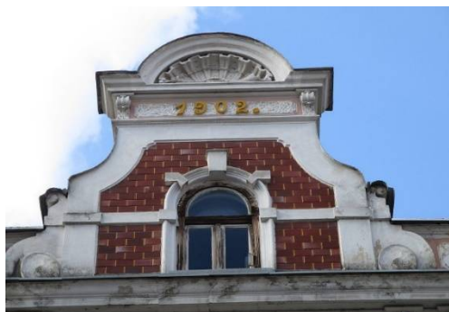
94. Bogat polkrožni zaključek žganega opečnatega pročelja meščanske hiše (1902) na Stanetovi ulici 3
