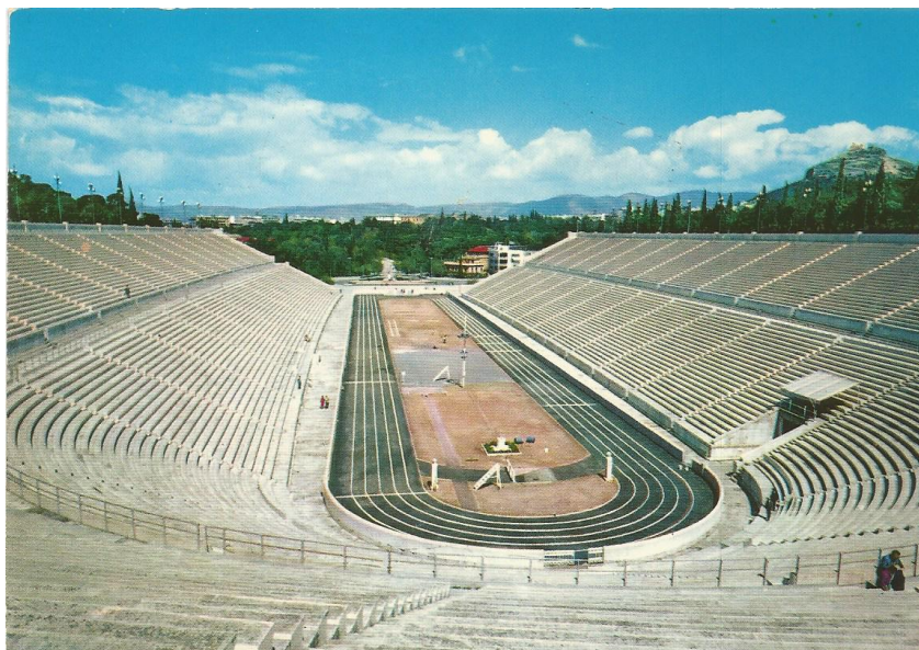
slika 31: MARMORNI STADION PANATHINAIKO V ATENAH (razglednica)
