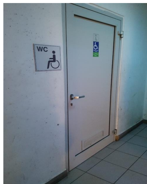
Slika 17: Vstopna vrata v stranišče, opremljena z oznako EVROKLJUČ (Čeh, 27. 12. 2016)
