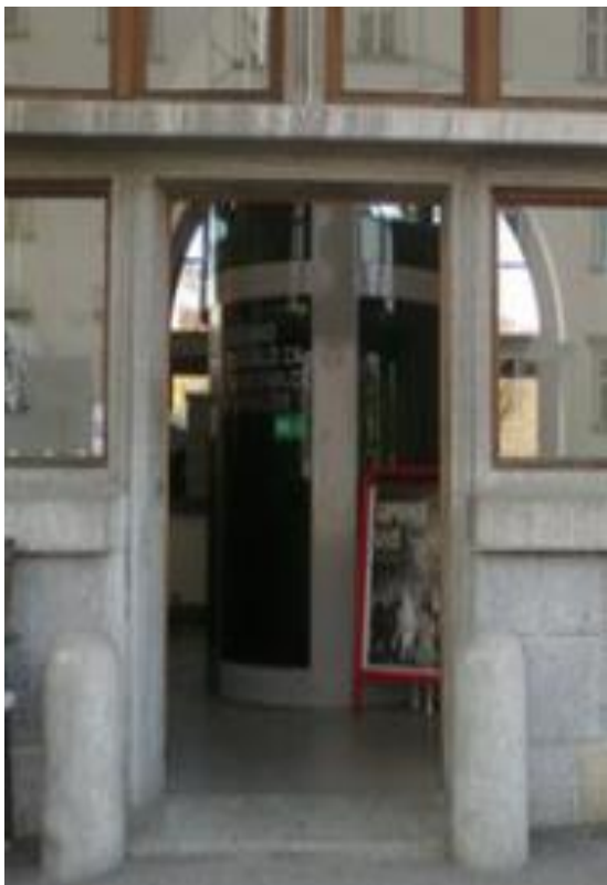
Slika 5: Vhod do dvigala Mesarskega mosta ( https://dostopnadjubljana.files.wordpress.com , 5. 2. 2017)
