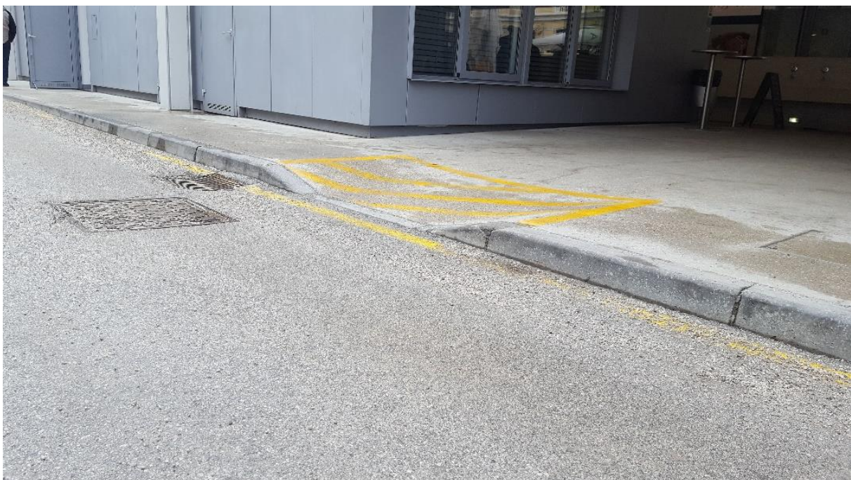
Slika 35: Urejena klančina za dostop do stranišča za invalide (Čeh, 7. 2. 2017)
