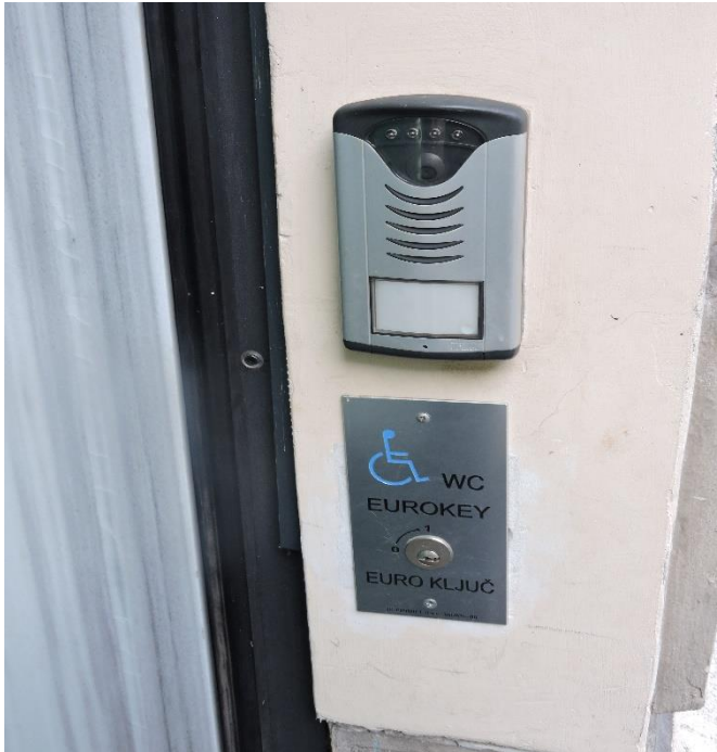
Slika 11: E-ključavnica in domofon ob vhodu v invalidske sanitarije (Čepin Tovornik, 27. 12. 2016)
