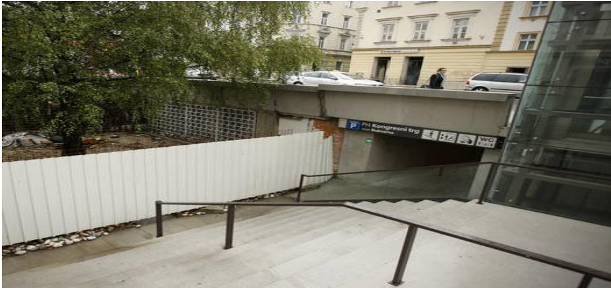
Slika 15: Stopnišče pri vhodu Bukvarna ( http://www.delo.si , 6. 2. 2017)
