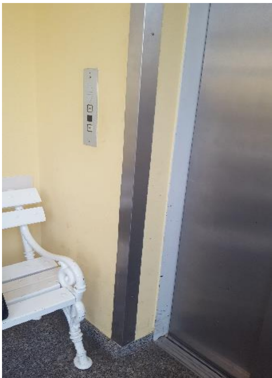
Slika 37: Ovira pri dostopu do stikala za priklic dvigala (Čeh, 28. 12. 2016)
