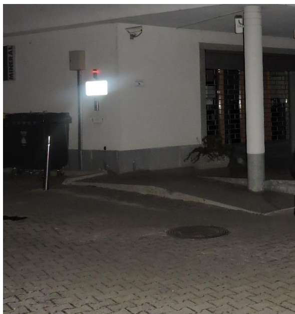
Slika 30: Urejena klančina za dostop do vhoda v stranišče (Čepin Tovornik, 27. 12. 2016)
