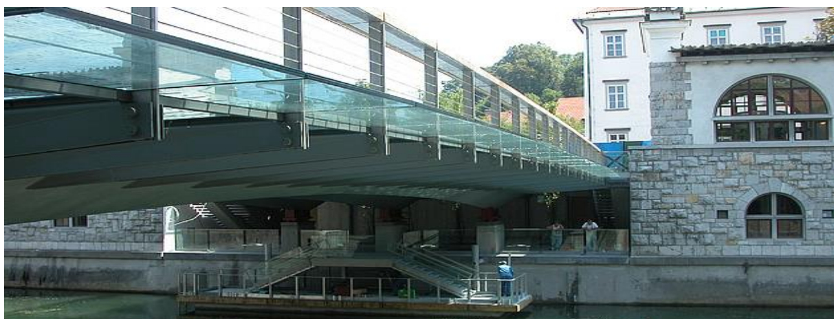
Slika 4: Podhod Mesarskega mosta ( http://www.ljubljana.si , 5. 2. 2017)
