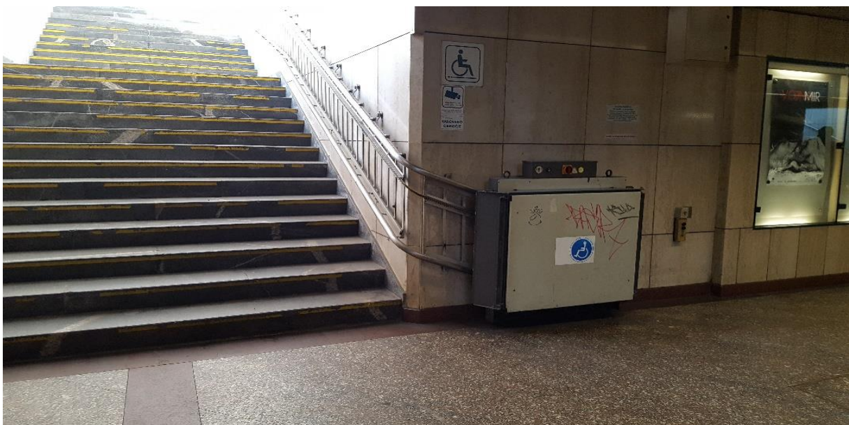
Slika 22: Stopnišče, ki vodi na peron, in invalidska dvizna ploščad (Čeh, 27. 12. 2016)
