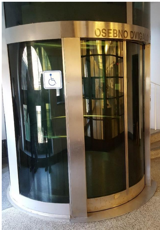
Slika 6: Dvigalo v podhodu Mesarskega mosta (Čeh, 27. 12. 2016)
