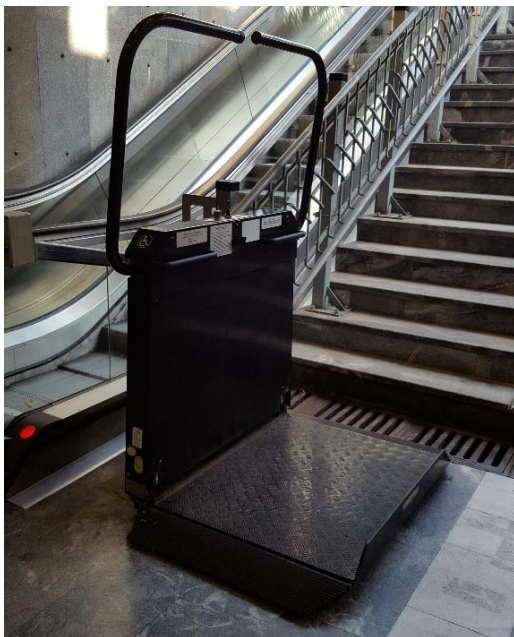
Slika 19: Dvizna ploščad v podhodu Ajdovščina (Čeh, 27. 12. 2016)
