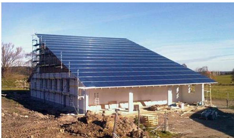
Slika 17: Integrirana sončna elektrarna [43]
