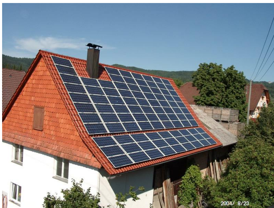
Slika 15: Sončna elektrarna na strehi [41]
