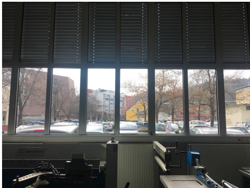
Slika 50: Nova okna v učilnici A-40
