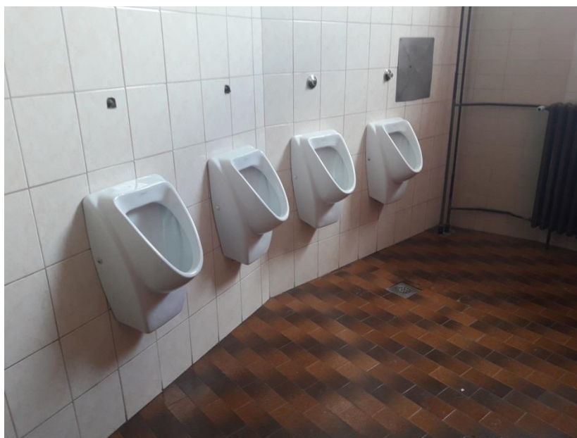
Slika 28: Zaporedno vezani senzori pri pisoarjih
