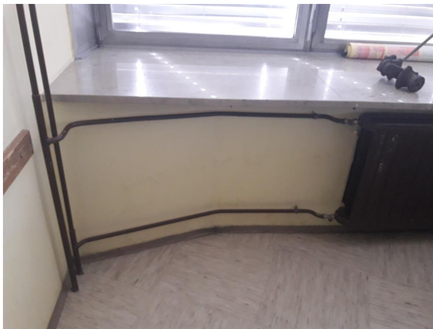
Slika 23: Na napeljavi ni izolacije
