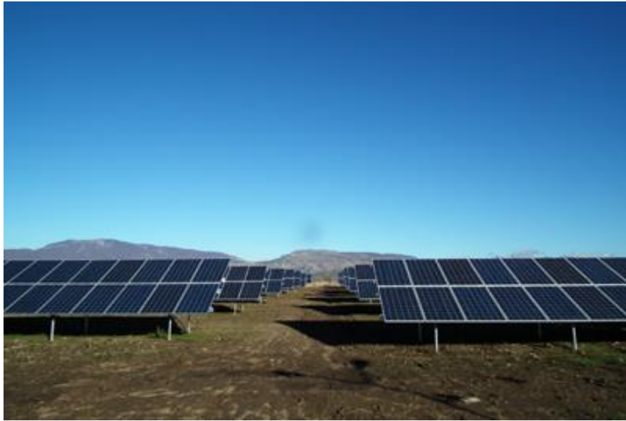
Slika 16: Prostostoječa sončna elektrarna [42]
