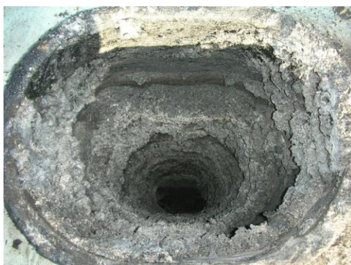
Slika 1: Saje v dimniški cevi v mali individualni kurilni napravi
