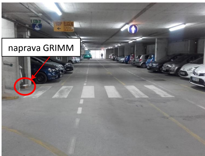
Slika 29: Merilno mesto v Parkirni hiši Glazija
