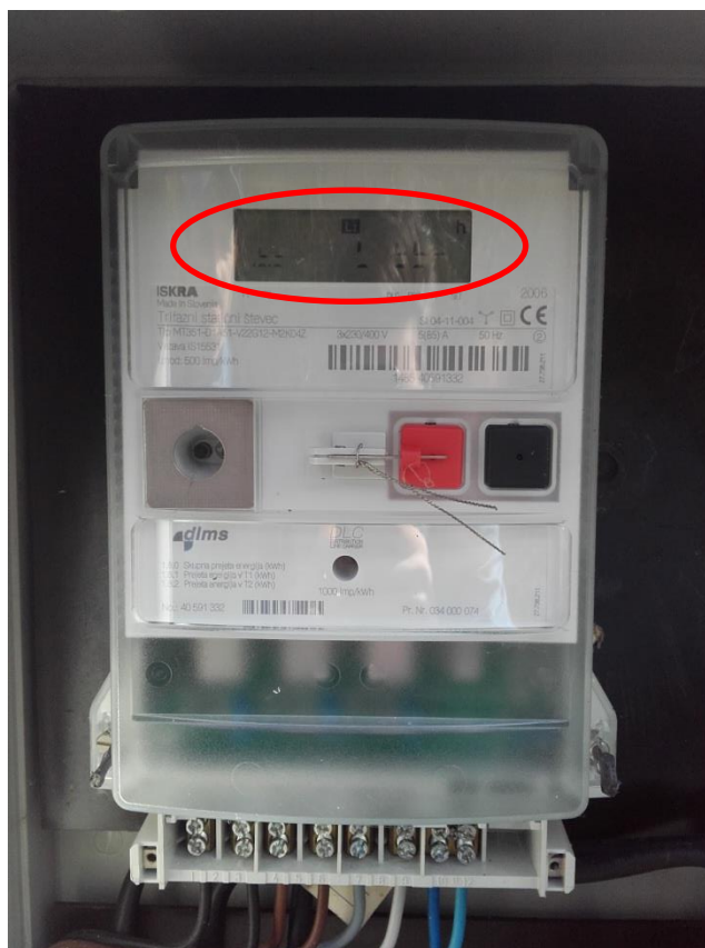
Slika 27: Prikaz starega pametnega števca Iskra tipa MT351.
