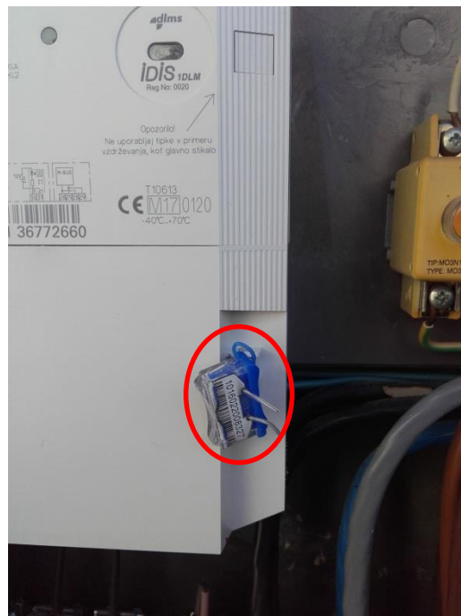
Slika 26: Prikaz na novo zaplombiranega pametnega števca.
