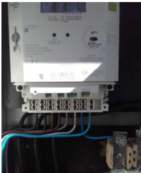
Slika 28: Prikaz namestitve novega pametnega števca Landys+Gyr E450.
