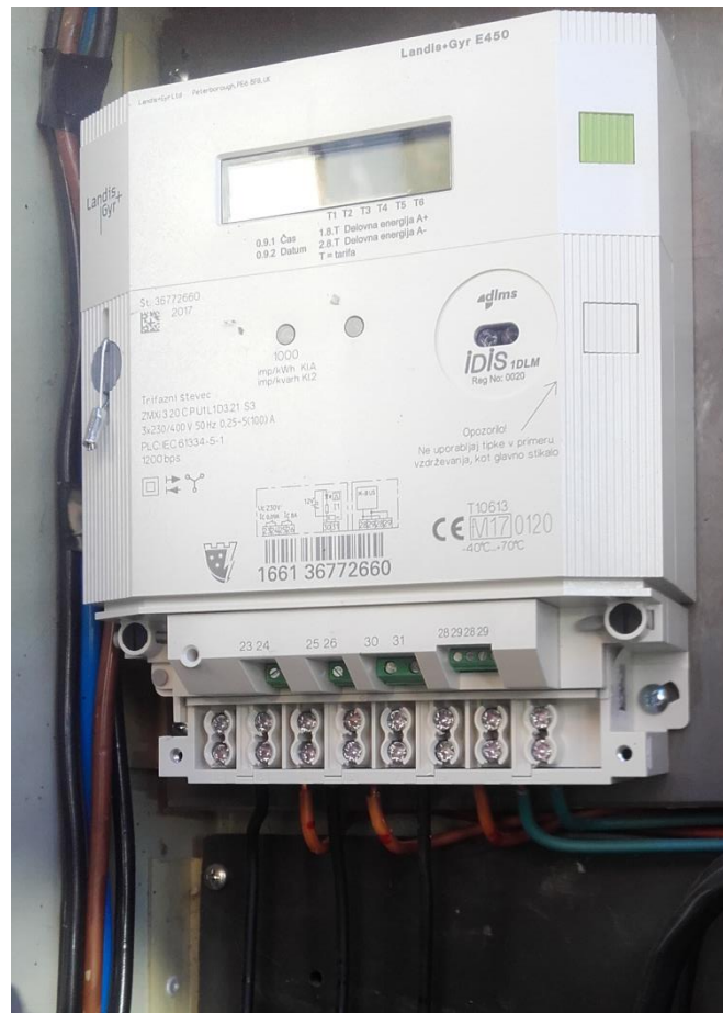
Slika 24: Prikaz namestitve pametnega števca na prejšnje mesto indukcijskega števca.
