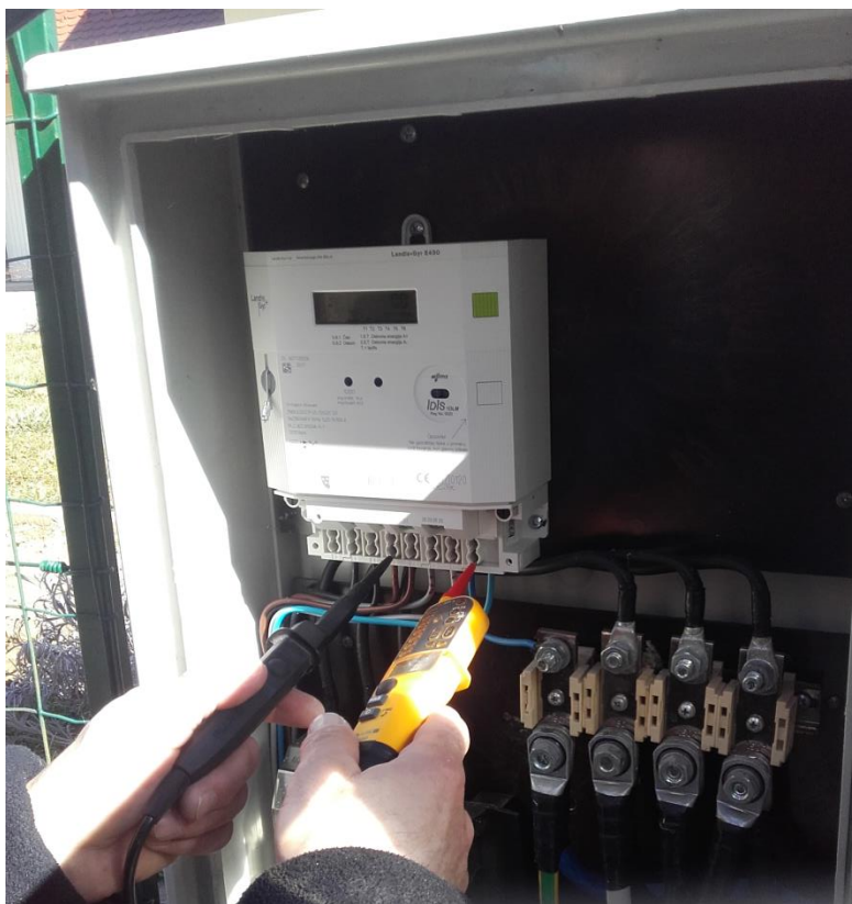
Slika 30: Prikaz preizkušanja števec z inštrumentom.
