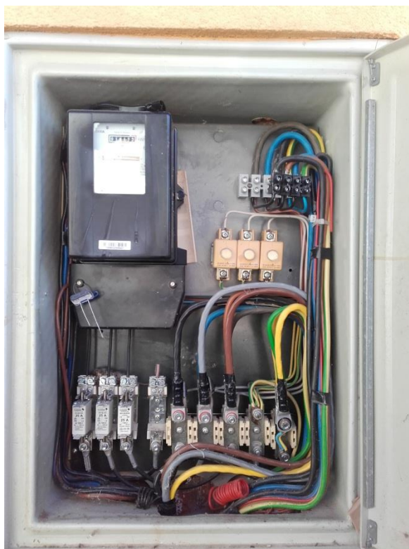
Slika 23: Prikaz starega trifaznega indukcijskega števca Iskra tipa T31CV-95, kateri bo zamenjan.
