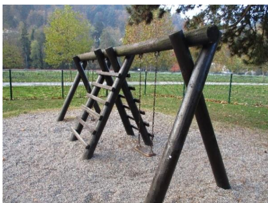
40. Savinjsko nabrežje - varnostna podlaga naj bo nameščena pod vsemi igrali, ki so višja od 0,6 m, in pod tistimi, kjer deluje "izsiljena sila" (gugalnice).
