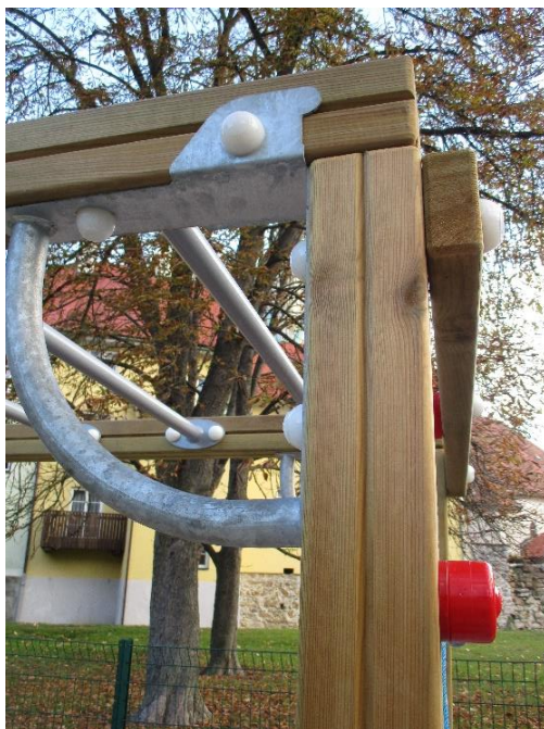
46. Savinjsko nabrežje - zaščiteni vijaki in matice na igralih iz kombiniranega materiala
