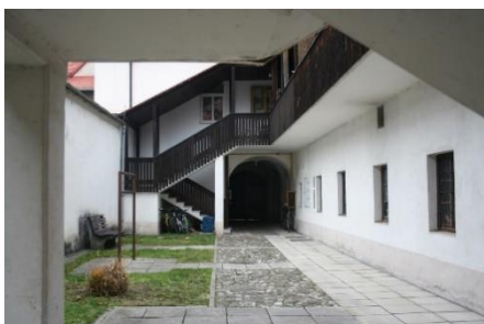
Slika 61: Majhno, dobro skrito dvorišče tik ob obzidju med Razlagovo ulico in gostilno Špital. Naslov obnovljene stavbe je Slomškov trg 5.
