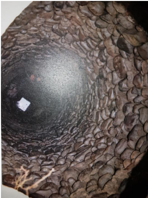
Slika 2: Notranjost vodnjaka v neposredni bližini dvorca.
