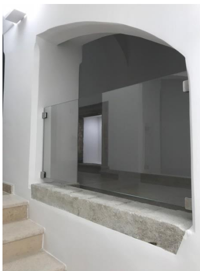
Fotografija 33: Steklena ograja na izvorni kamniti osnovi. (Avtor fotografije: Nejc Ocvirk)
