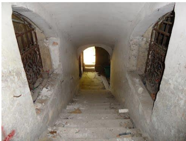
Fotografija 16: Prikazuje osrednje stopnišče v dvorec. Vidne so železne rešetke, ki so med današnjo obnovo izginile in so nadomeščene s kaljenim steklom. (Vir: osebni arhiv lastnika dvorca)
