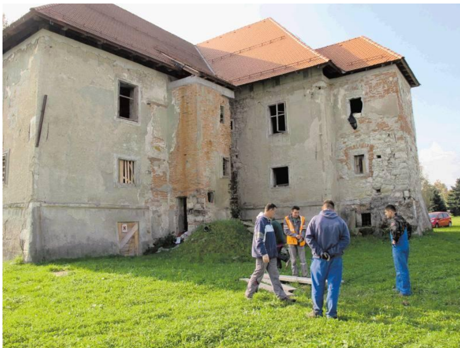
Fotografija 12: Prikazuje dvorec v fazi, ko se je začela temeljita obnova. (Vir: osebni arhiv lastnika dvorca)
