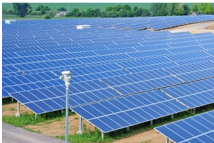
Slika 7: Sončna elektrarna na tleh [15]
