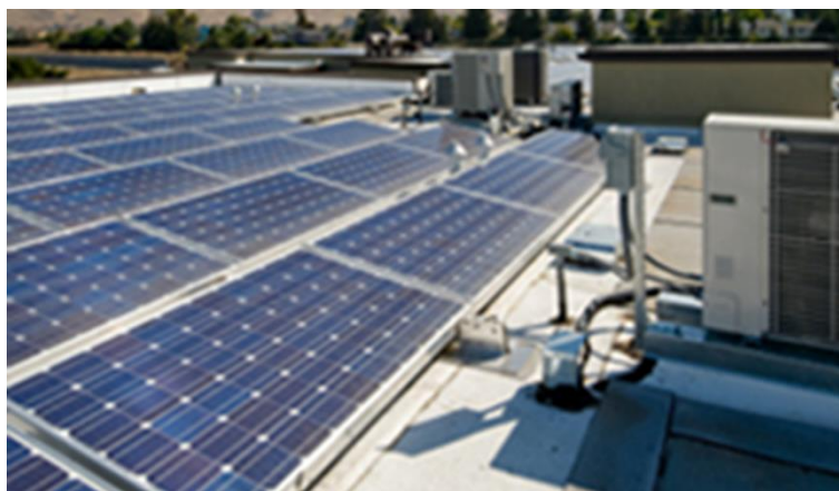
Slika 6: Sončna elektrarna na poslovni stavbi [14]
