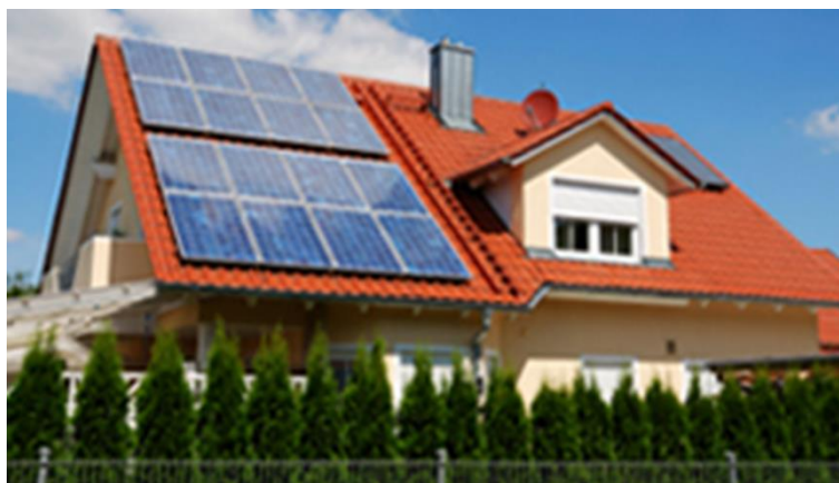
Slika 5: Primer sončne elektrarne na hiši [13]
