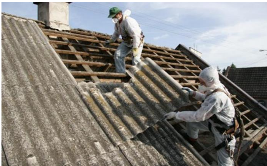
Slika 6: Odstranjevanje lesonitnih plošč [13.]
