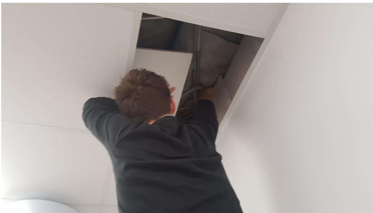
Slika 18: Zapiranje spuščnega stropa po montaži krmilne enote
