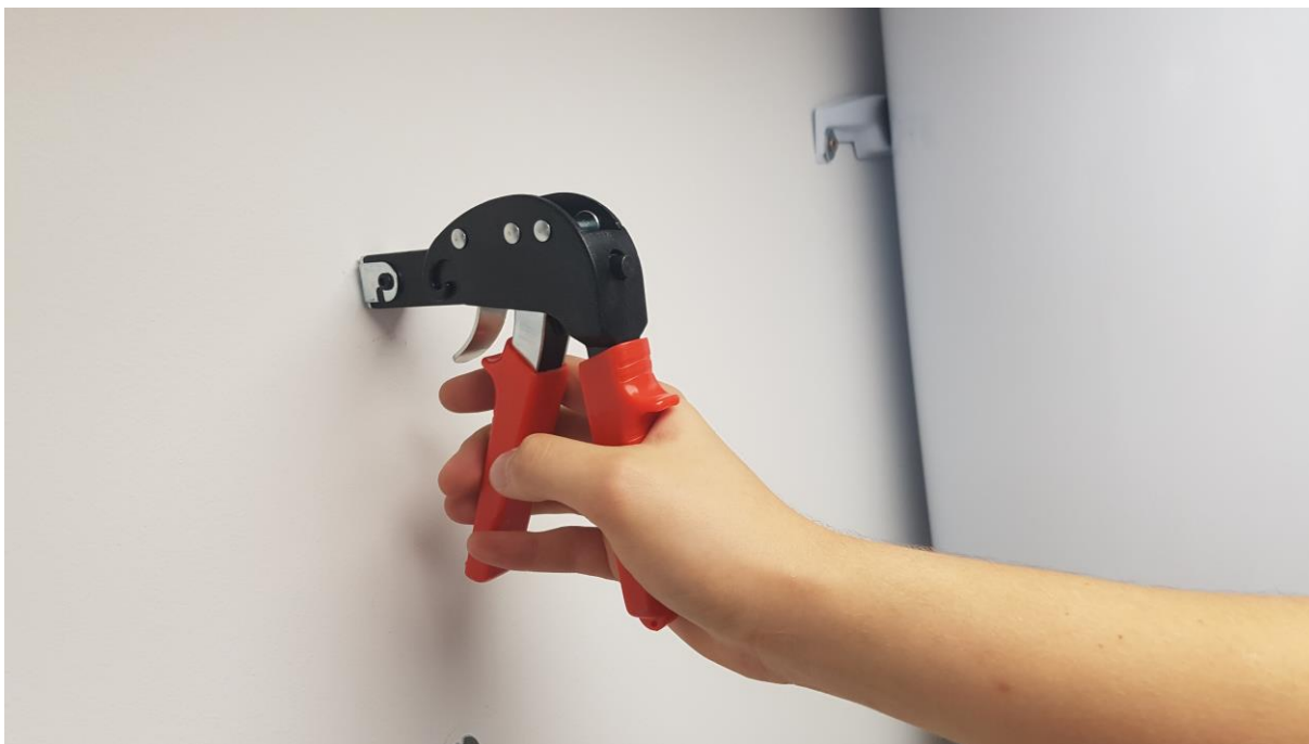
Slika 19: Vstavitev zidnih vložkov
