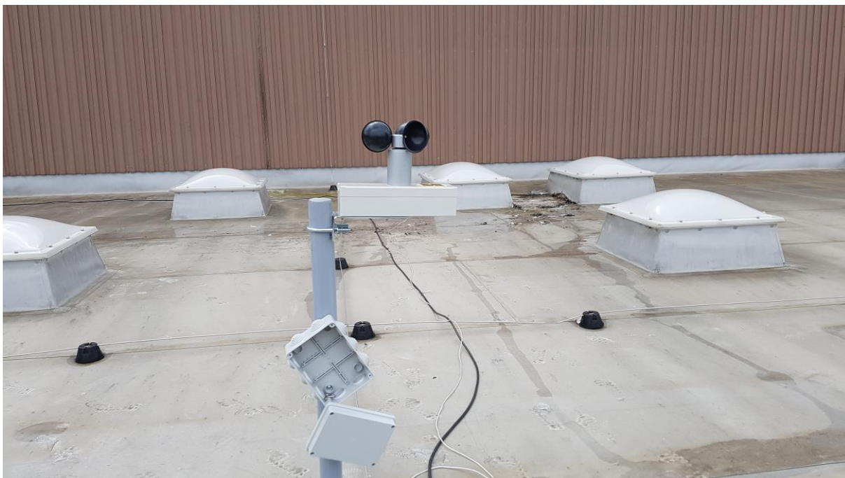
Slika 23: Montaža vremenske postaje
