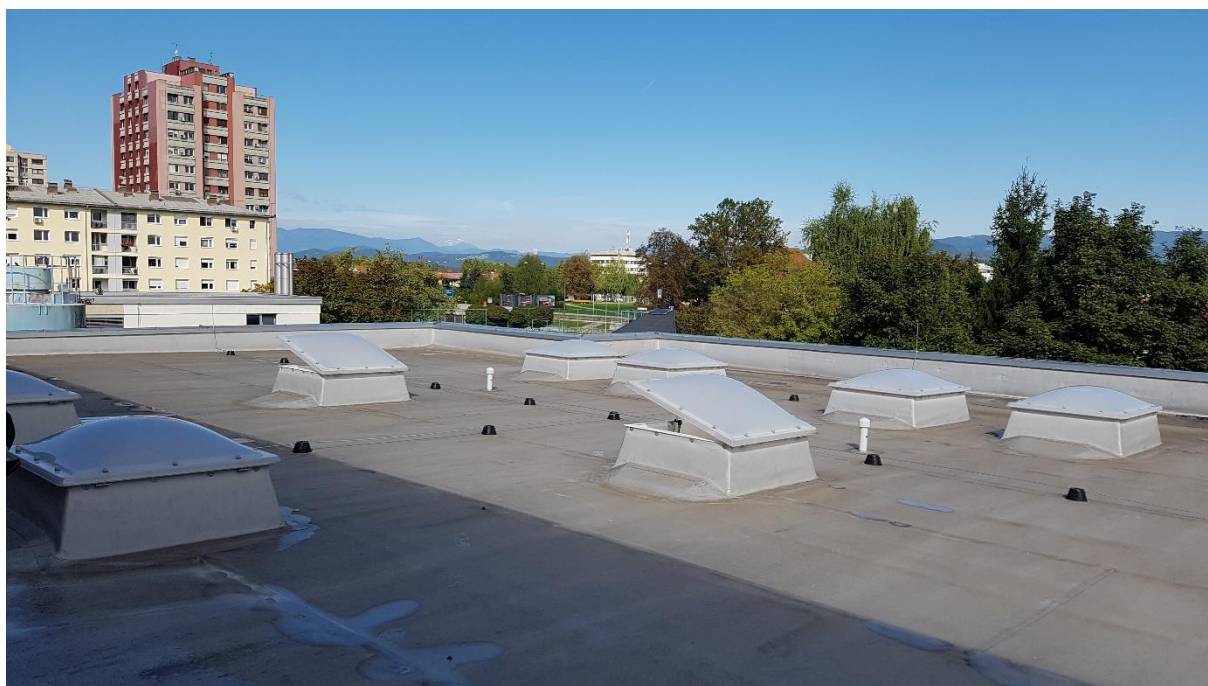
Slika 1: Pogled na strešne kupole
