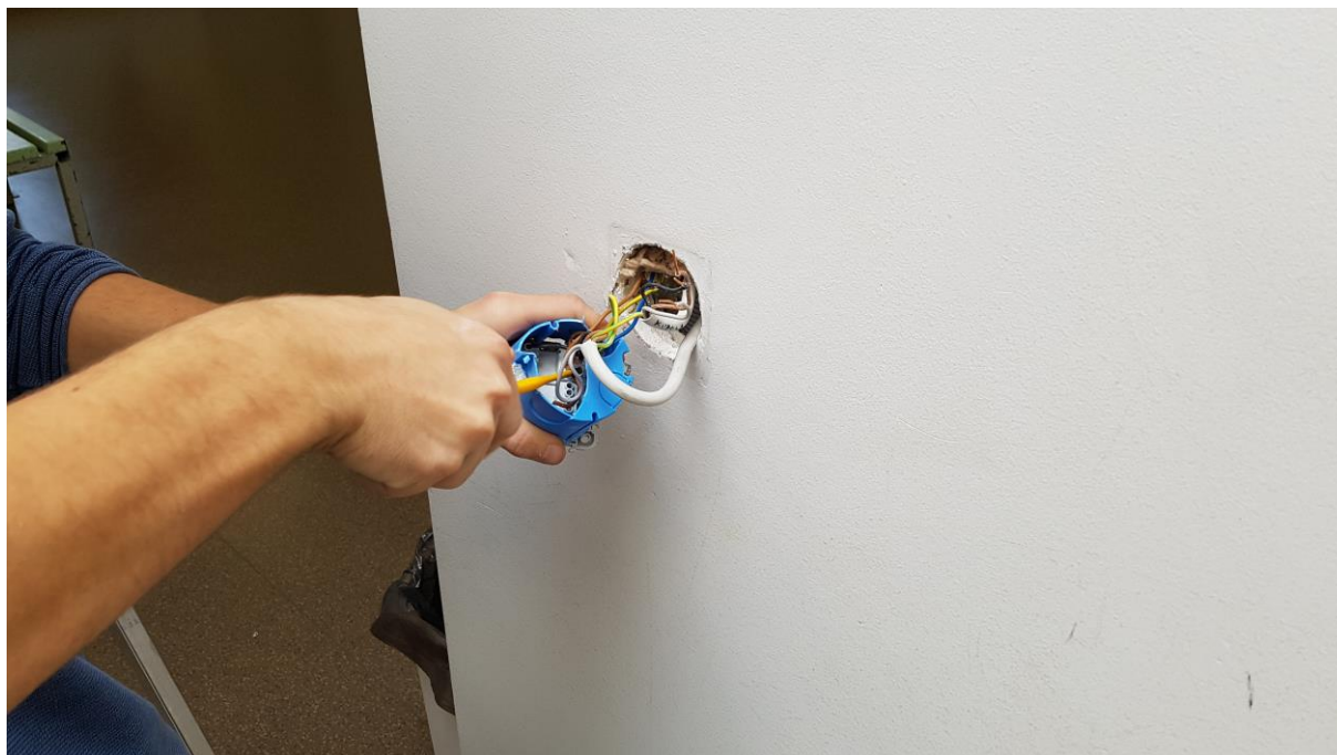
Slika 14: Odstranitev obstoječe napeljave
