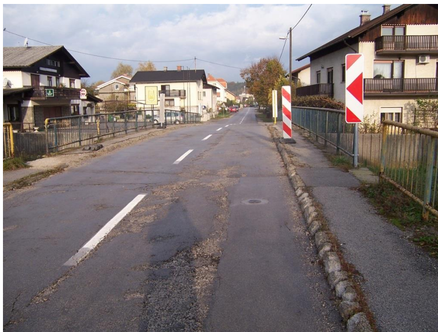
Slika št. 16: Most na cestnem odseku Cesta na Ostrožno
