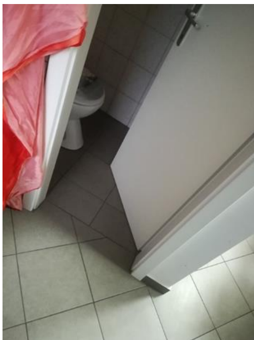
Slika 131: Vhod v sanitarije (Ravnjak, 11. 1. 2018)
