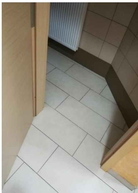
Slika 118: Vhod v sanitarije (Ravnjak, 11. 1. 2018)
