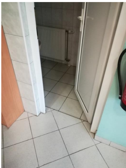
Slika 110: Vhod v sanitarije (Ravnjak, 11. 1. 2018)
