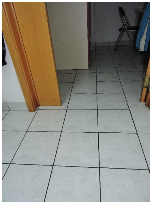
Slika 78: Vhod v sanitarije (Ravnjak, 11. 1. 2018)
