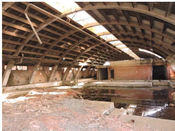
Slika 28: Notranjost industrijske opekarnе Ljubečna (Čepin Tovornik, 2017)
