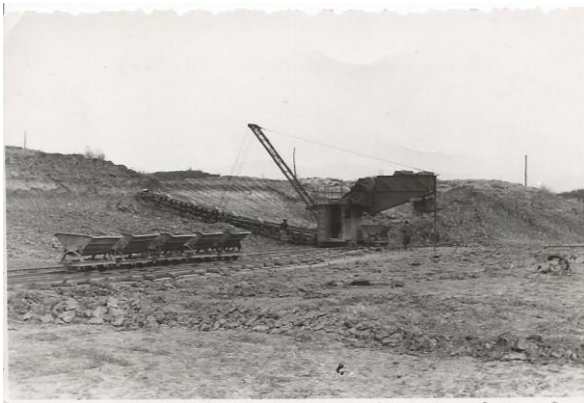
Slika 1: Kopanje in nalaganje gline na transportne vozičke, Kolenik, 1959 (Grosek, 2018)
