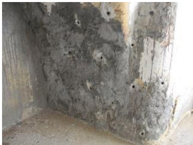
Slika 38: Izvrtane luknje za injektiranje betona iz notranje strani jugozahodnega trakta dvorca. Foto: Bojan Rebernak.
