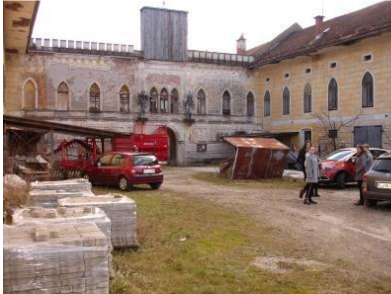
Slika 45: Zunanje odprto dvorišče je polno gradbenega materiala in strojev. Foto: Bojan Rebernak.
