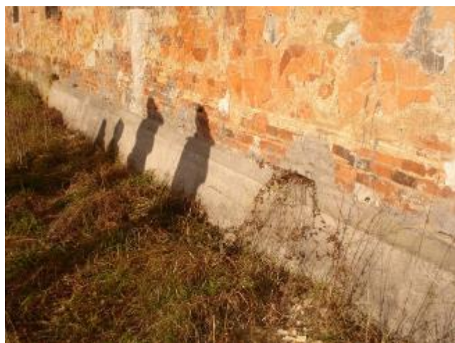
Slika 39: Ojačitev temelja iz zunanje strani jugozahodnega trakta dvorca. Foto: Bojan Rebernak.
