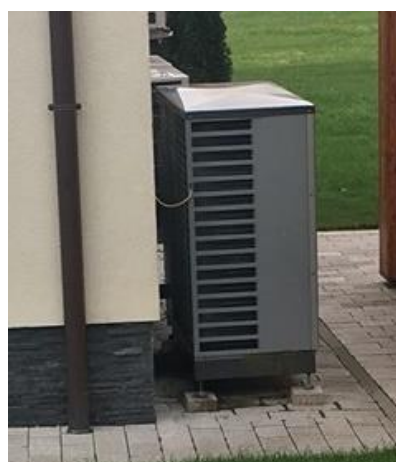
Slika 6: Medena vas – prikaz uporabe toplotne črpalke
