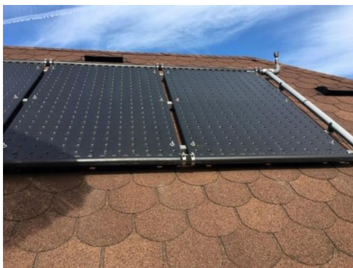
Slika 13: Koča na vasi – uporaba sončnih celic za ogrevanje bazenske vode
