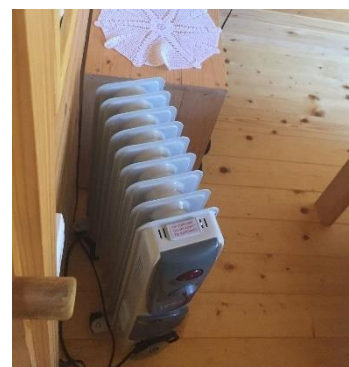
Slika 19: Glamping Savinja – ogrevanje z električnimi radiatorji
