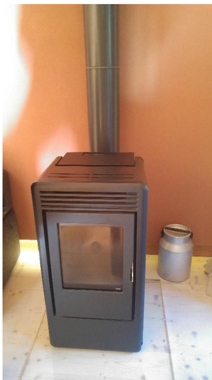
Slika 28: Hiša Raduha – ogrevanje stanovanja v stari štali s pečjo na pelete
