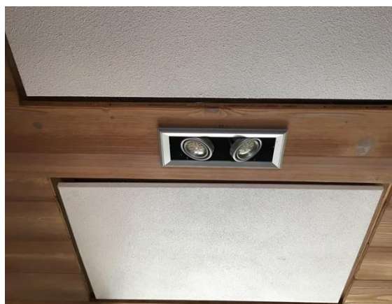
Slika 27: Hiša Raduha – ogrevanje drevesne hiške z IR paneli
