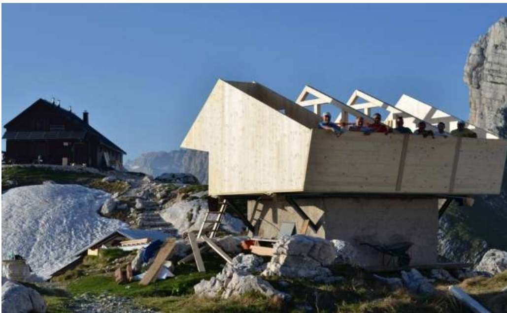
Slika 5 Gradnja bivaka na Prehodavcih
