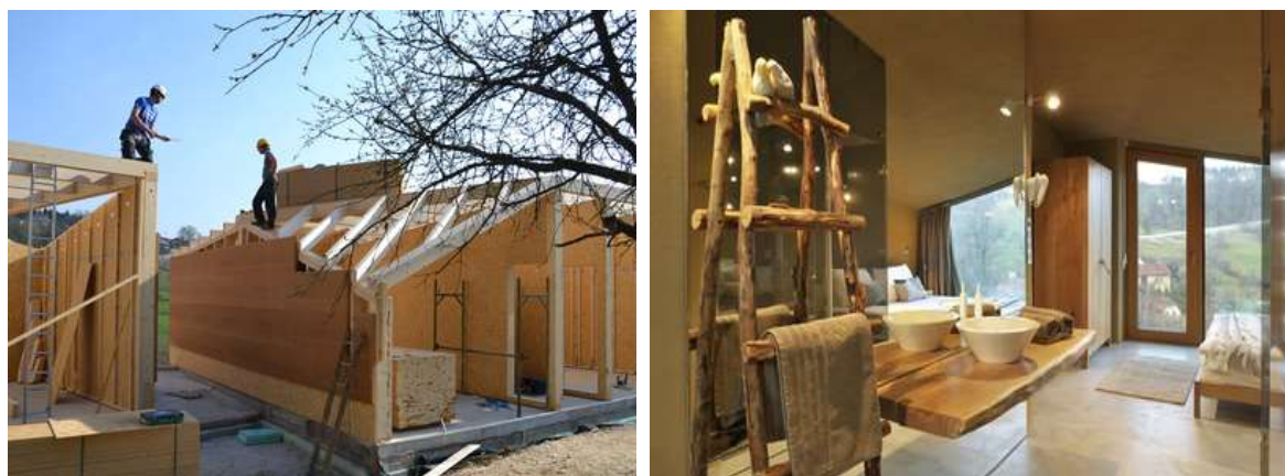
Slika 25: Gradnja glampinga in notranjost
