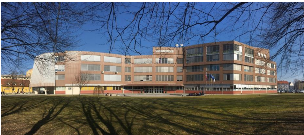
Slika 4.1: Južna stran stavbe, kjer se izvaja poučevanje
