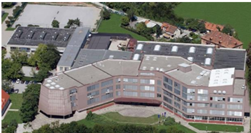
Slika 1.1: Zgradba Šolskega centra Celje
