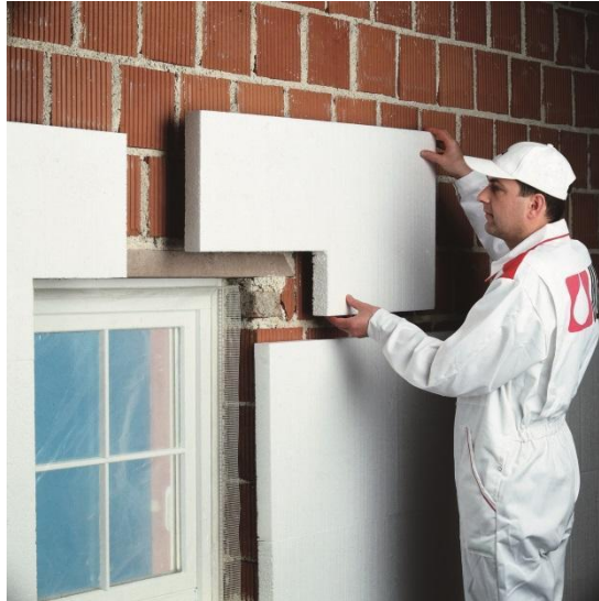
Slika 3.3: Polaganje ekspandiranega polistirena [4]
