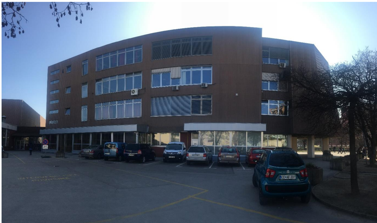
Slika 4.2: Zahodna stran šole, kjer je del oken že bil zamenjan
