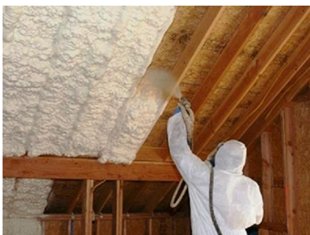
Slika 3.5: Vgradnja poliuretanske pene [6]
