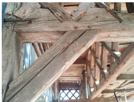
Slika 15: Levo spajanje lesnih elementov z kovinskimi sponami (klamfe) – novi del, desno spajanje lesnih elementov z lesenimi klini – stari del [15]
