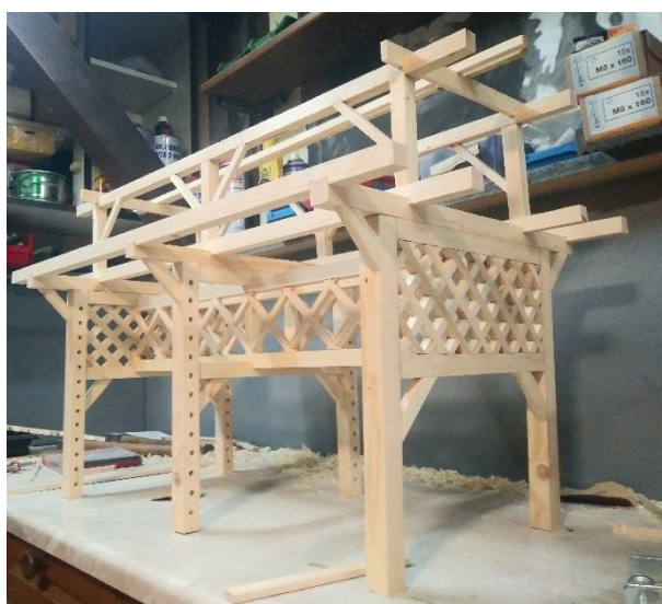
Slika 25: Dodan vezni hodnik (gank) in postavljeni nosilci špirovcev (koza) [25]
