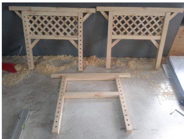
Slika 22: Zlepljeni stebri in tramovi, vstavljene križne vezi in roke [22]
