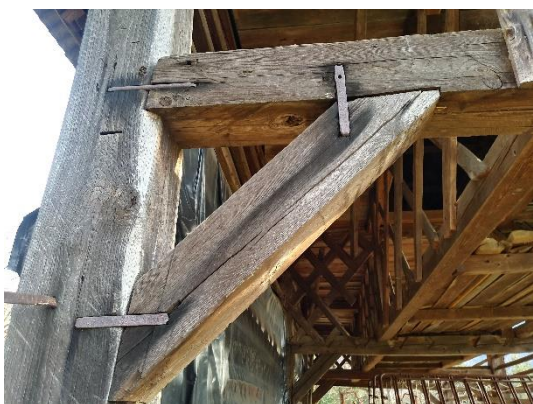
Slika 15: Levo spajanje lesnih elementov z kovinskimi sponami (klamfe) – novi del, desno spajanje lesnih elementov z lesenimi klini – stari del [15]
