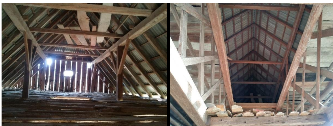
Slika 18: Konstrukcija ostrešja [18]
