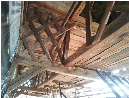
Slika 16: Izžagane križne vezi starega dela kozolca za namen povečave [16]
