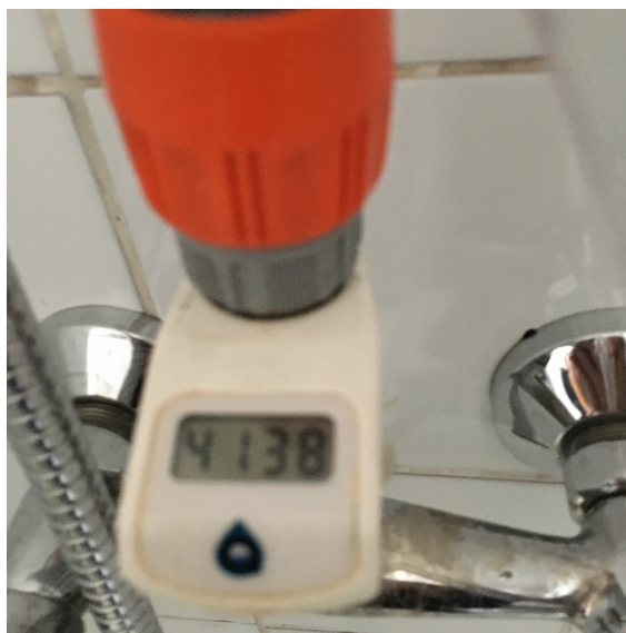
Slika 23: Merilnik pretoka vode nameščen na izbrani kontrolni izlivki – tuš
