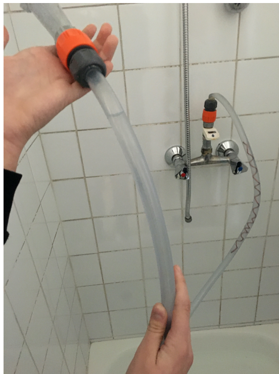
Slika 36: Zastajanje vode v prozorni cevi kontrolne izlivke – tuš
