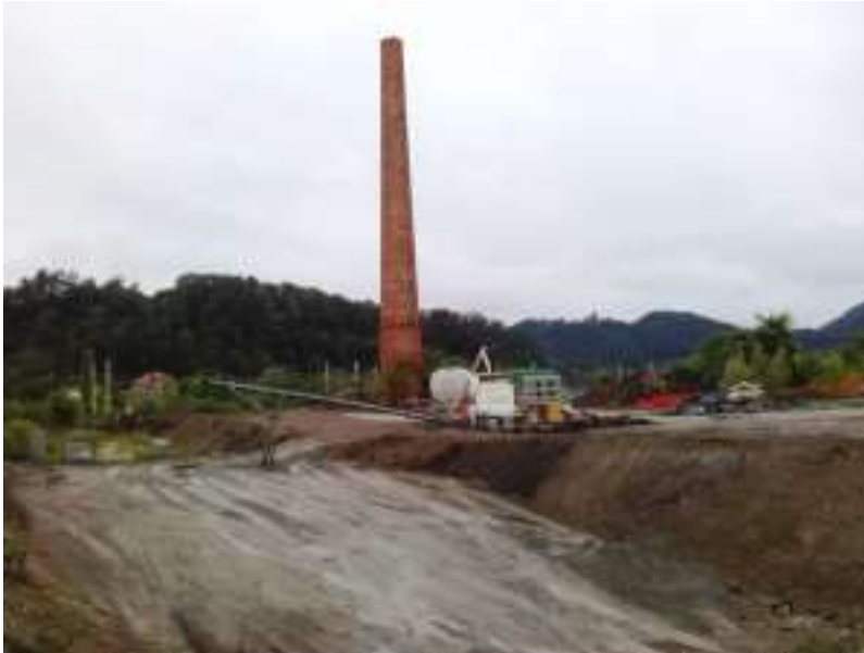
Slika 2: Sanacija vrhnjega sloja kontaminirane prsti na območju stare Cinkarne Celje. Vir: https://www.celje.info/aktualno/obcina-celje-tozi-cinkarno/ Pridobljeno dne, 16. 11. 2019.
