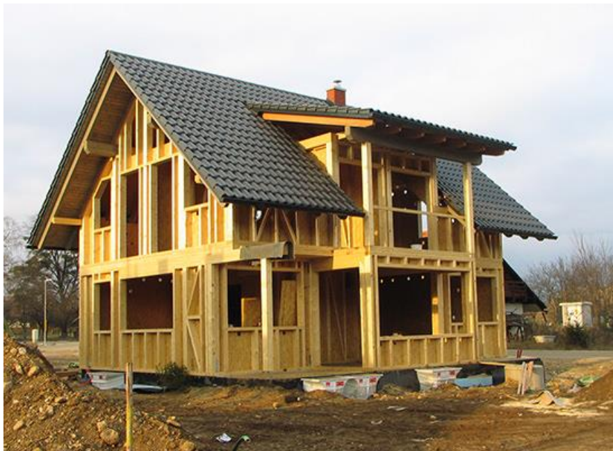
Slika 11: Primer skeletne gradnje
