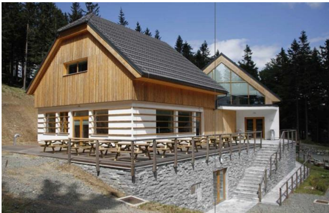
Slika 1: Primer dobre prakse lesene gradnje
