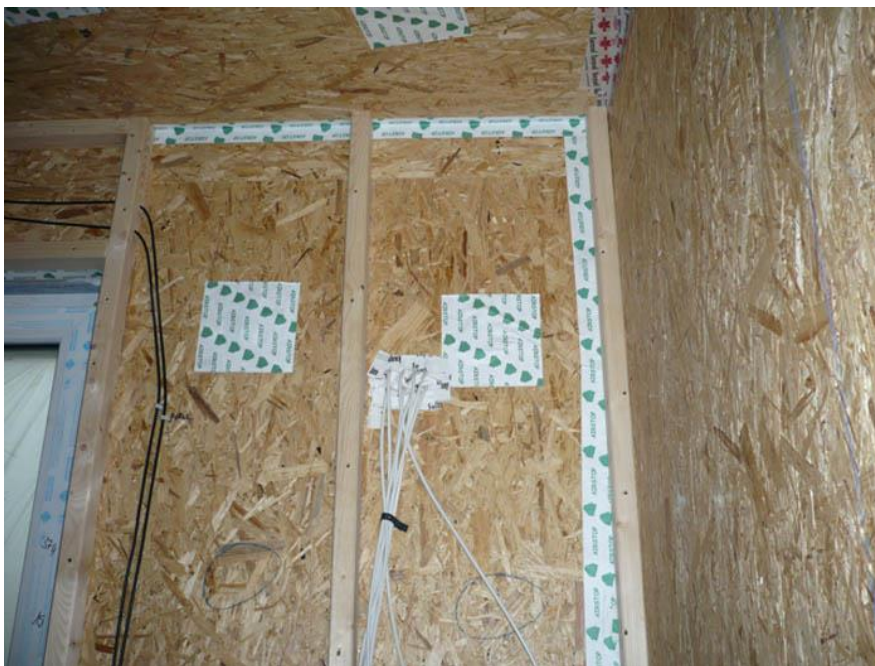
Slika 7: Tesnjenje pasivne hiše
