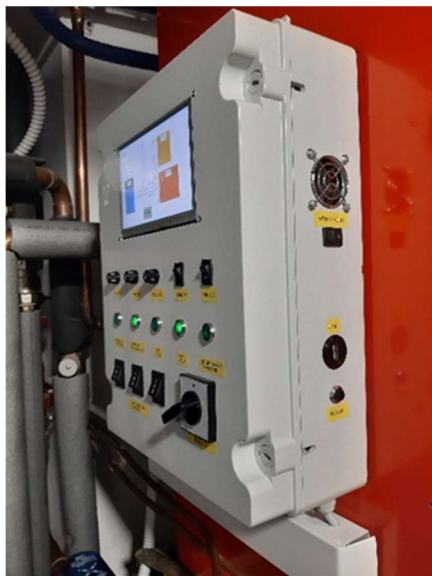
Slika 43: Namestitev omarice v kurilnici
