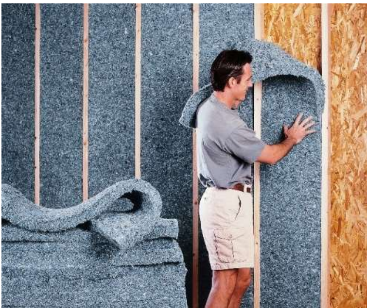
Slika 92: vgradnja bombaža kot toplotno izolacijo
