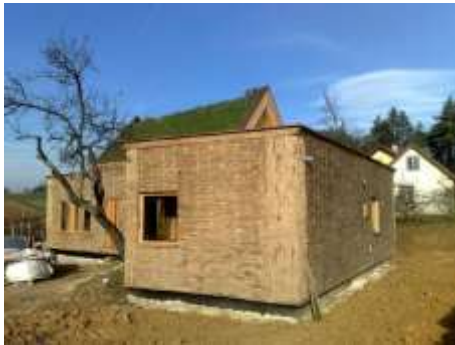
Slika 54: gradnja slamnate hiše, Lahovna
