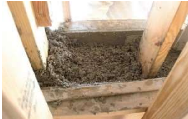
Slika 75: priprava mešanice konopljinega betona
