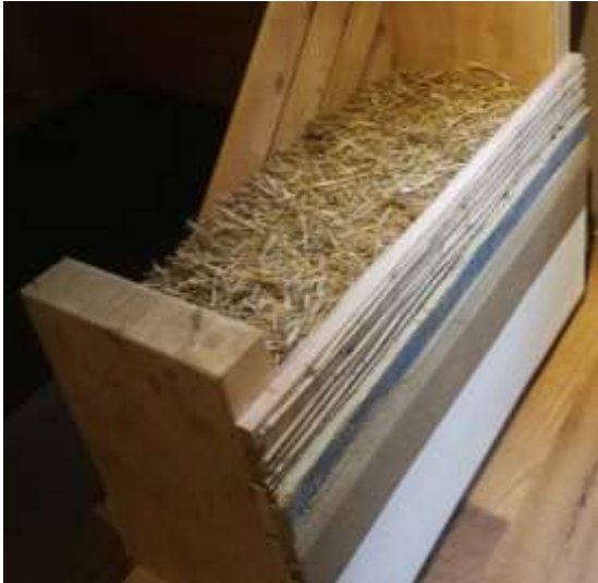
Slika 103: vzorčni prerez stene
