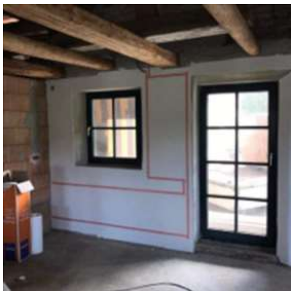
Slika 147: izgled pri vgradnji Carbon ogrevanja
