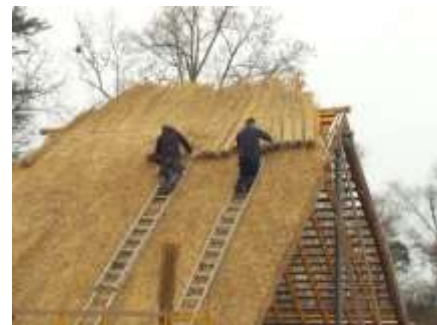
Slika 48: gradnja slamnate strehe
