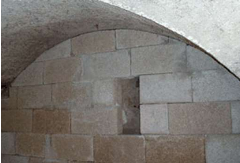
Slika 72: zid iz konopljinih zidakov
