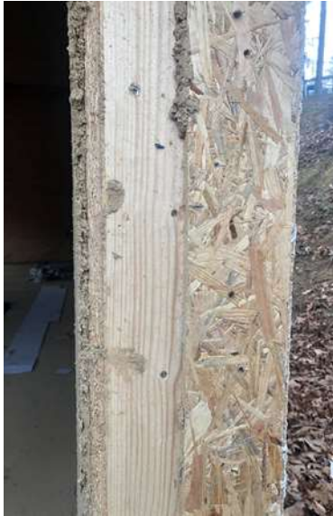
Slika 141: prerez stene
