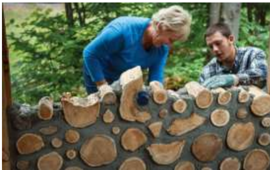
Slika 40: tehnologija gradnje cordwood
