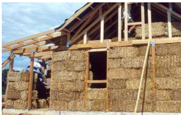
Slika 50: gradnja hiše iz slamnatih bal
