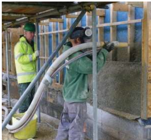
Slika 74: brizganje konopljinega betona
