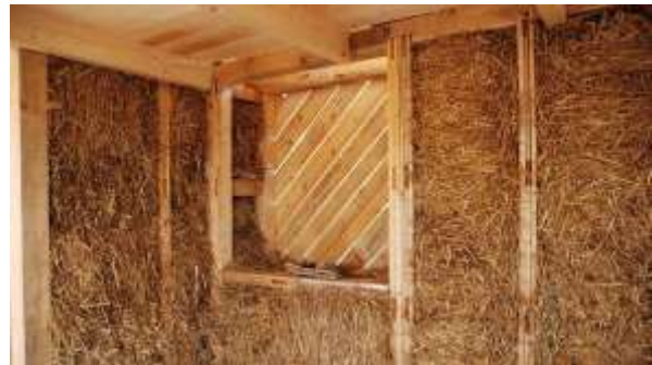
Slika 51: stena iz slamnatih bal
