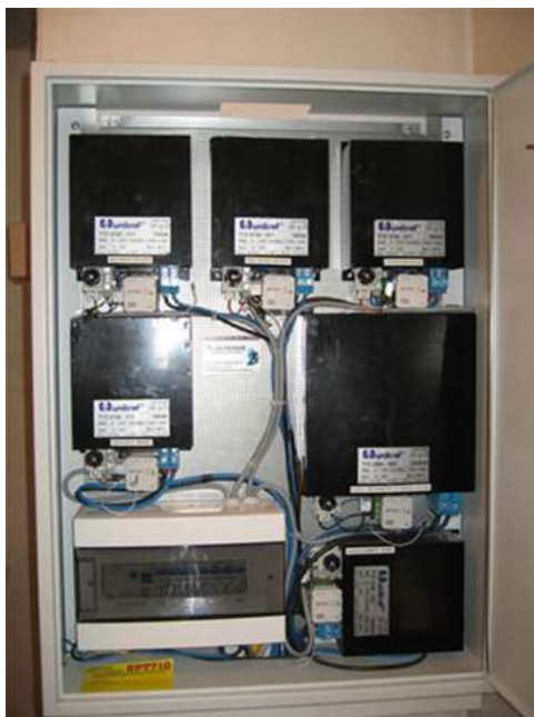
Slika 144: set kablov in transformatorjev
