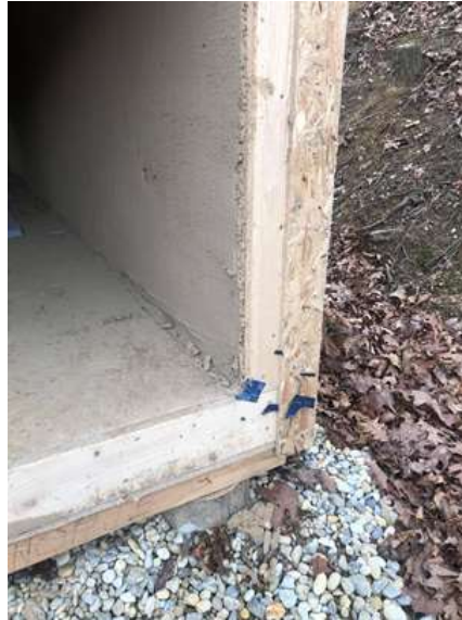
Slika 140: prerez stene in poda
