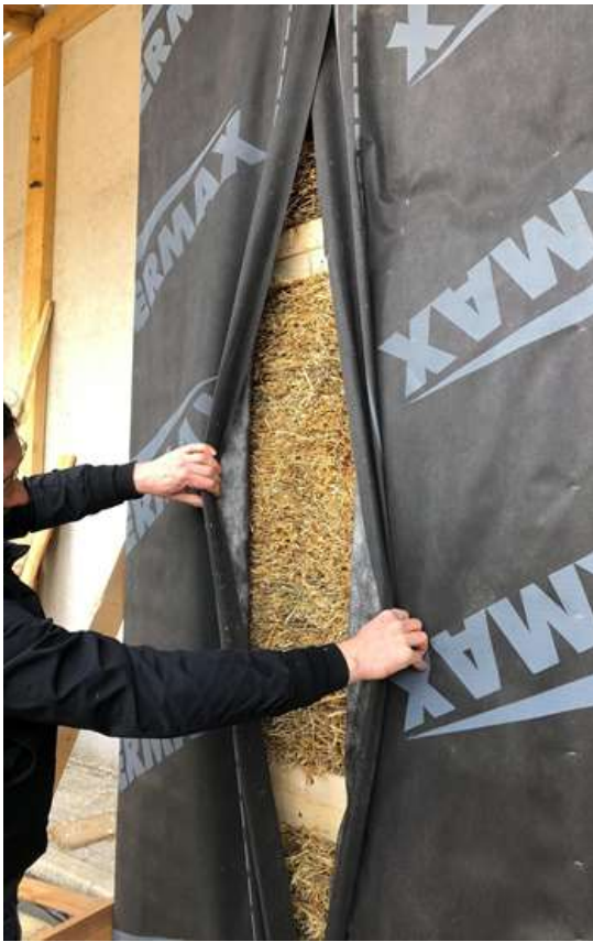
Slika 119: uporaba slamnih bal v stenah
