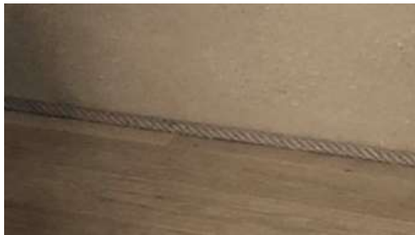
Slika 132: lanena vrv na stiku med podom in steno
