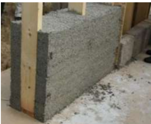
Slika 73: prerez stene in konopljinega betona
