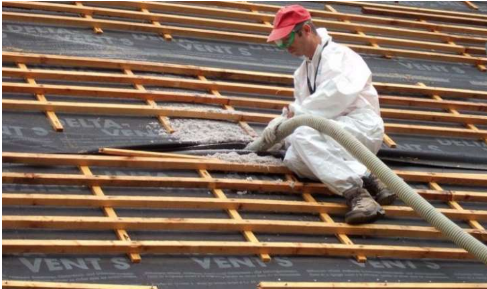
Slika 86: vgradnja celuloznih kosmičev
