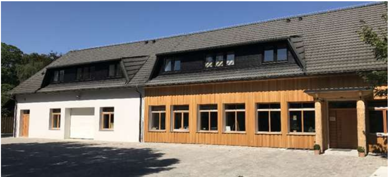
Slika 112: poslovna stavba podjetja Gnezdjo
