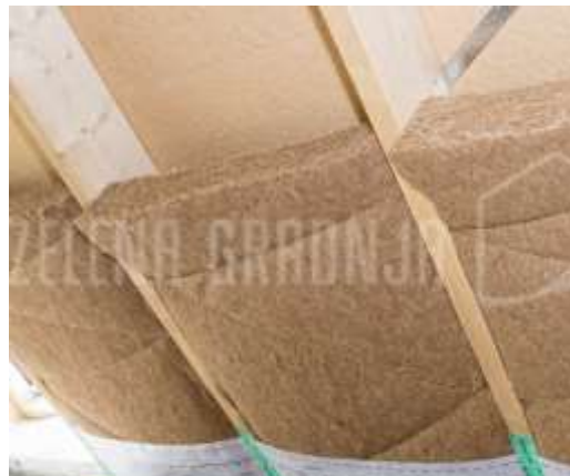
Slika 101: vgradnja jute
