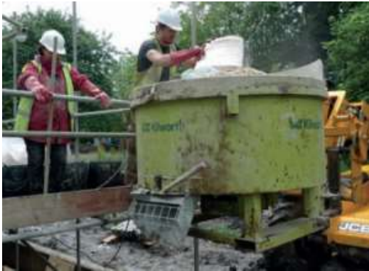
Slika 76: vgrajevanje konopljinega betona
