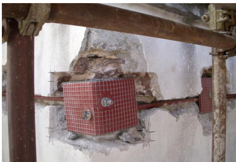
Slika 51: Primer vgraditve protipotresnih elementov v star objekt
