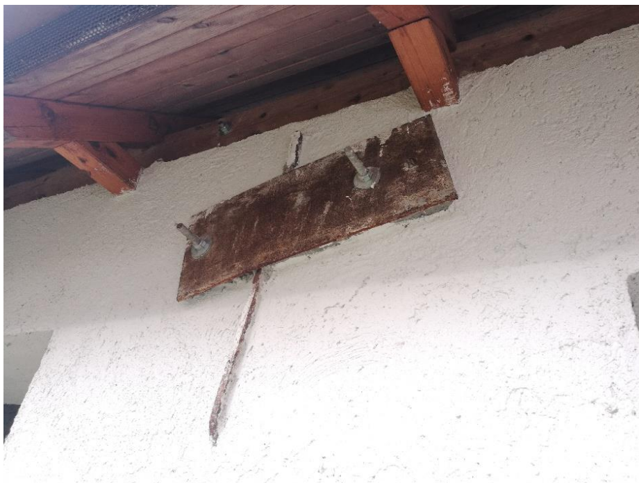
Slika 53: Primer rešitve protipotresne varnosti
