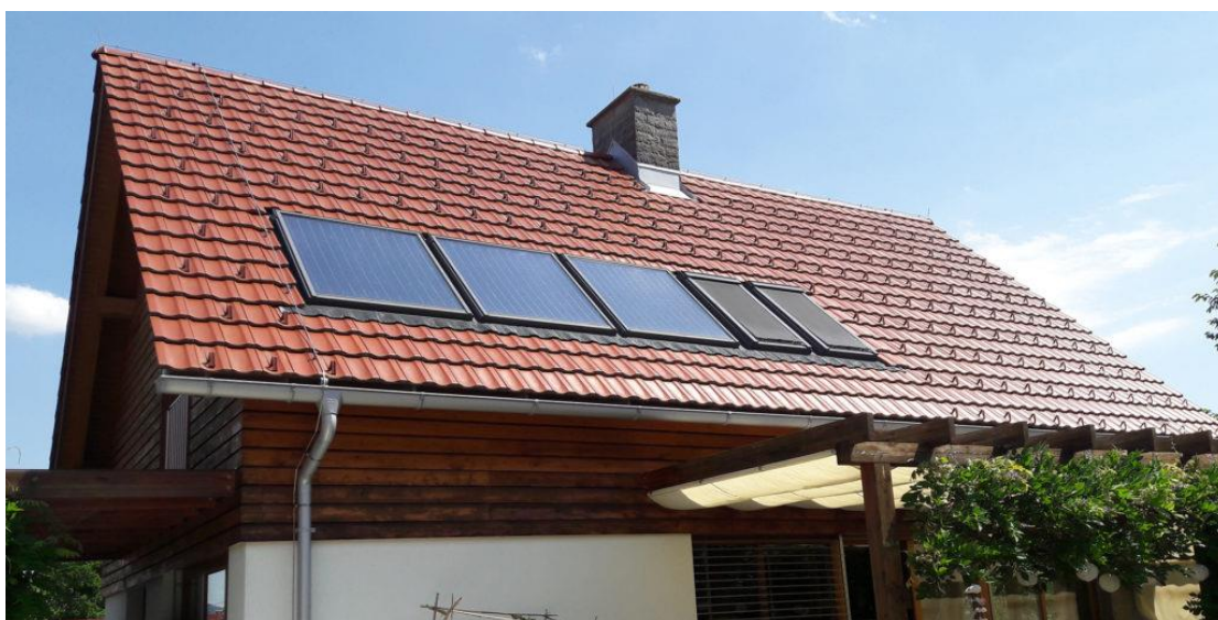
Slika 47: Primer izdelave strelovoda na opečnati strehi
