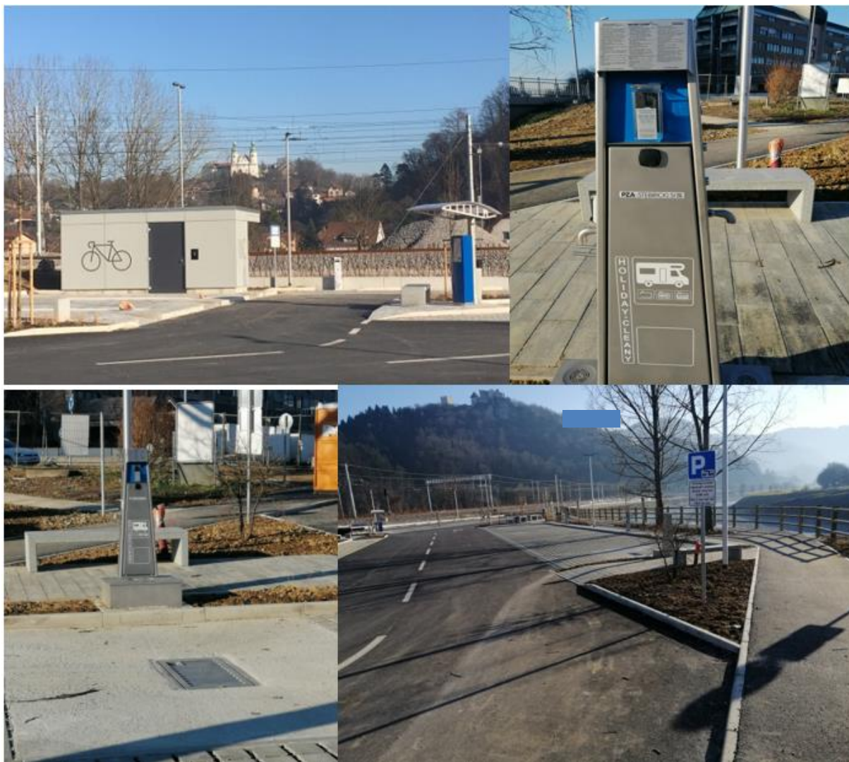
Slika 36: Fotografije parkirišča Park & Ride v izgradnji 68
