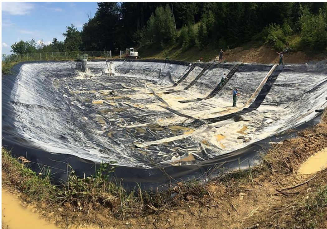
Slika 25: Izgradnja akumulacijskega jezera smučišča Celjska koča ( https://www.sinteza-lining.si/vodnazajetjaakumulacije ; dostop 8. 3. 2020)
