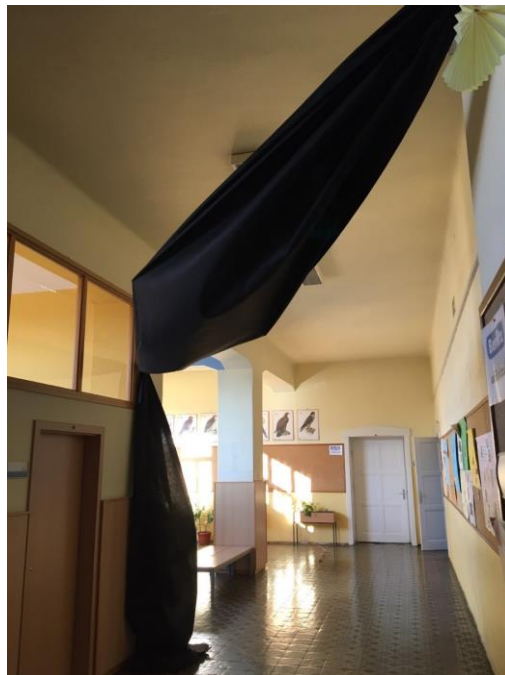
Slika 18: Zvočno-absorpcijski element – paneli-jadra iz polnila in tkanine na hodniku
