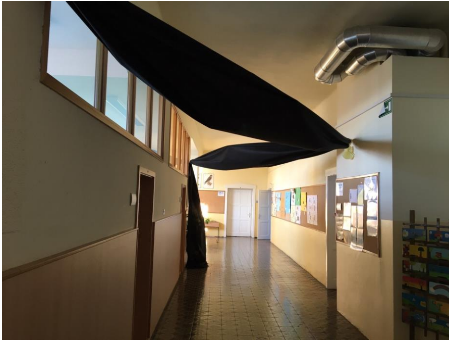
Slika 19: Absorpcijski element – paneli-jadra iz polnila in tkanine na hodniku
