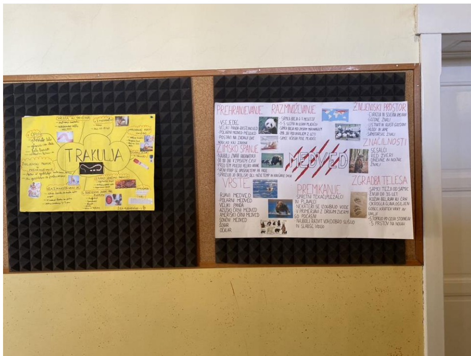
Slika 20: Zvočno-absorpcijska elementa – plošči iz pene na hodniku
