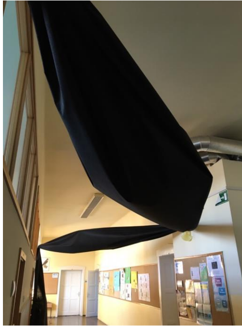
Slika 17: Zvočno-absorpcijski element – paneli-jadra iz polnila in tkanine na hodniku
