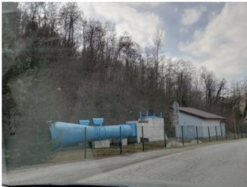
Slika 4: Ventilator za prezračevanje jame "jamska pluča" (Lasten vir.)
