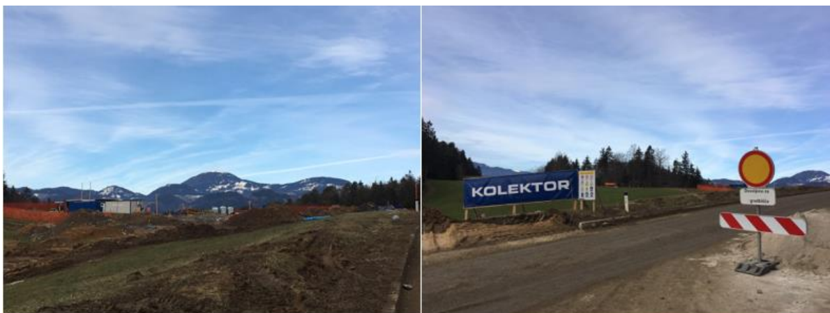
Slika 14: Začetek gradbenih del v Gaberkah, 30. 1. 2021 14
