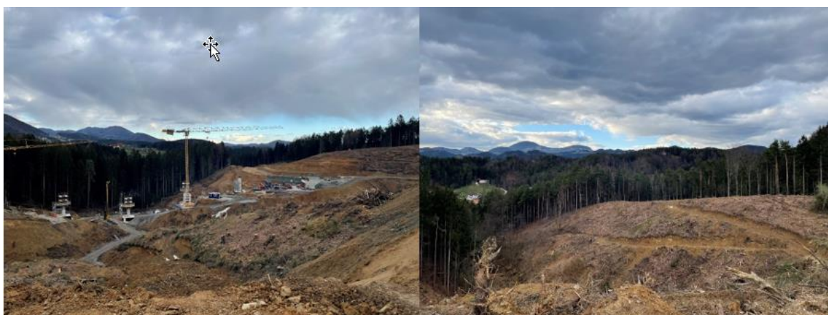
Slika 17: Gradnja v Gaberkah, 3. 4. 2021 17
