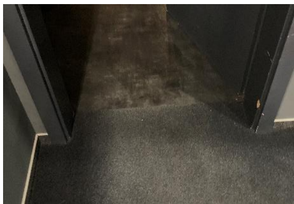
Slika 38: Vhod v zaodrje (Avtorica: Tina Šket 28. 1. 2021)
