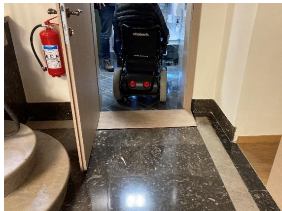
Slika 10: Vhod v sanitarije in klančina (Avtorica: Tina Šket, 28. 1. 2021)
