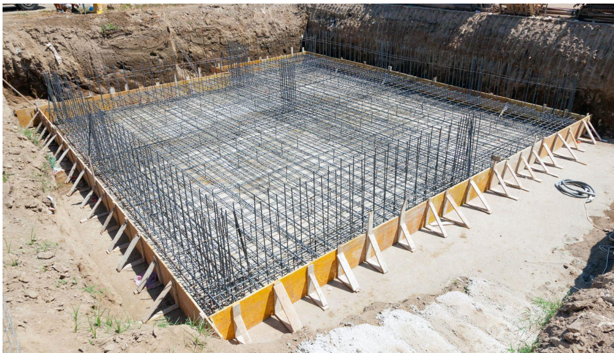
Slika 26: Armirana plošča
