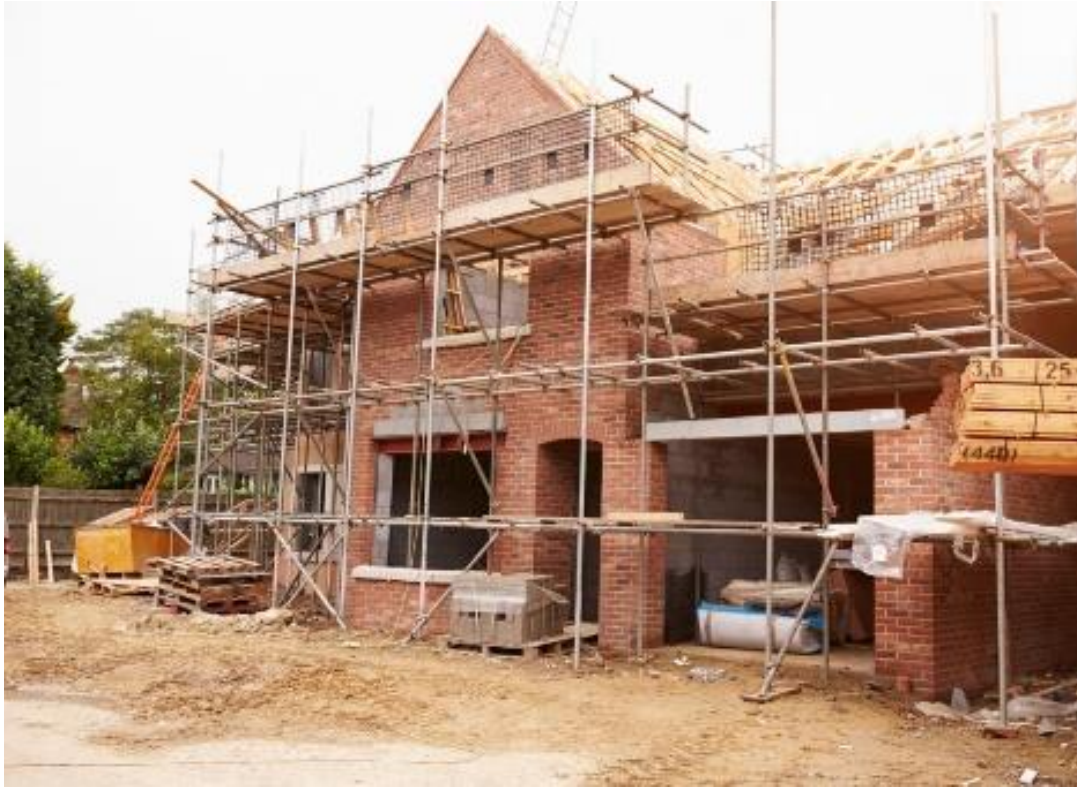
Slika 30: Tretja gradbena faza
