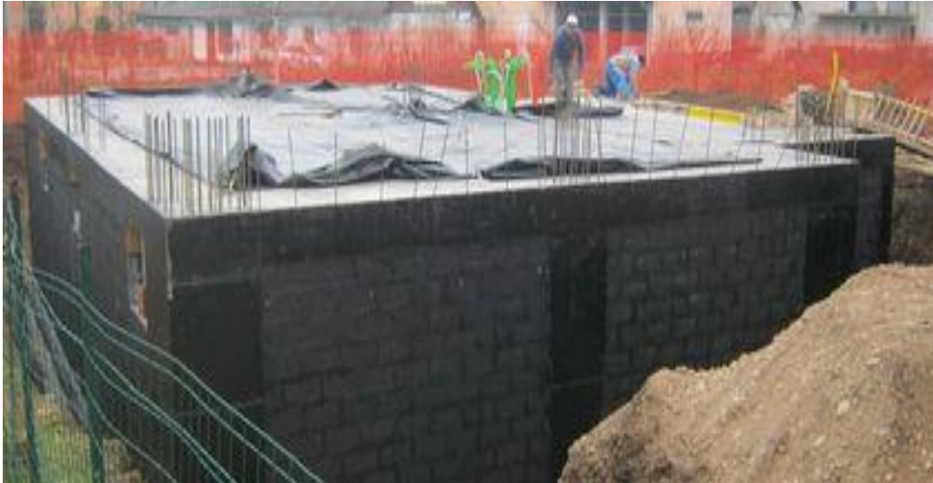
Slika 29: Druga gradbena faza
