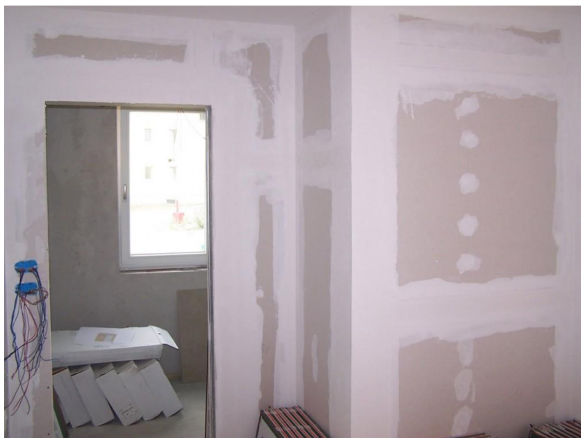
Slika 31: Četrta gradbena faza
