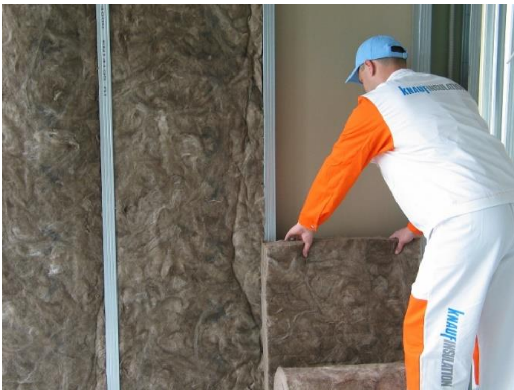
Slika 25: Stenska izolacija
