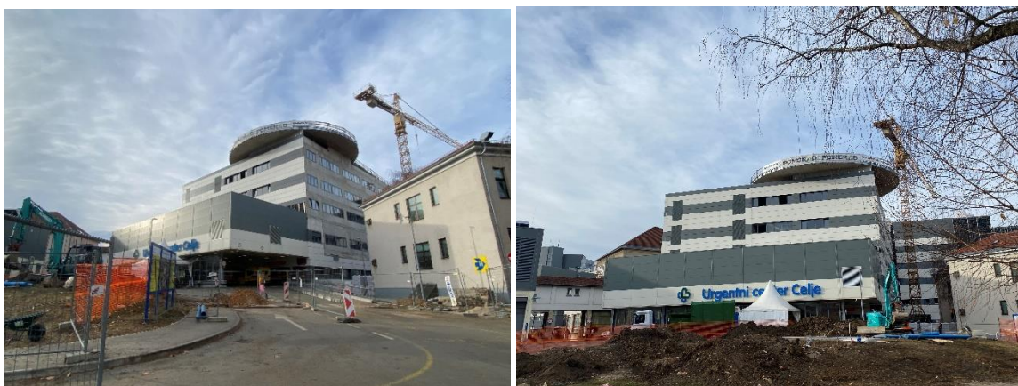
Slika 38 in 39: Gradbišče okrog bolnišnice in gradnja Urgentnega centra Celje
