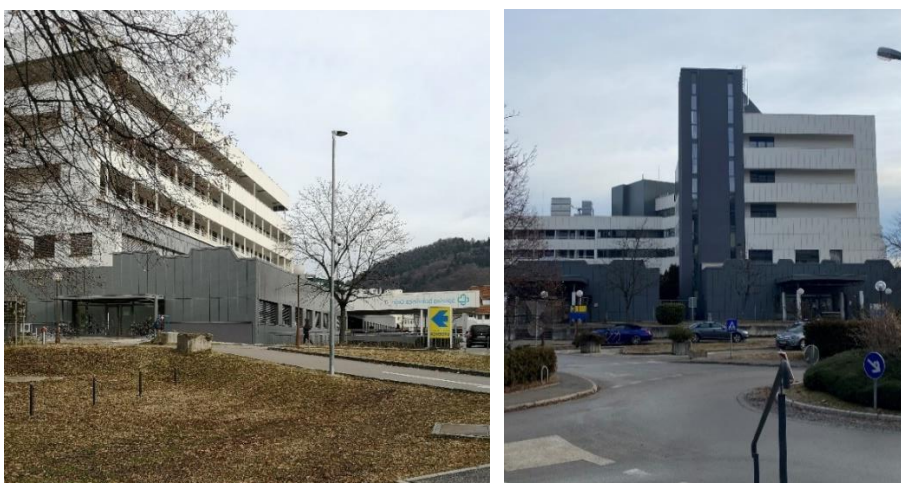
Sliki 32 in 33: Prenovljeni del bolnišnice (zahodna stran)
