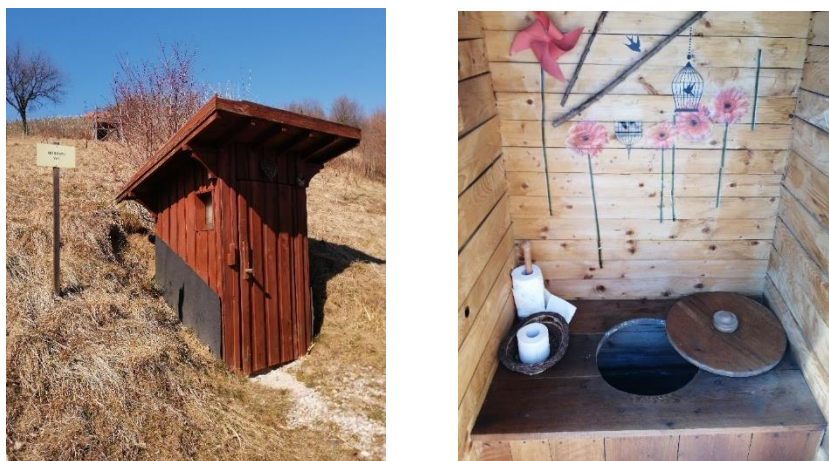
Slika 21: Kompostno stranišče s podzemnim sistemom cevi, ki vodijo kompost do obdelovalnih površin 31
