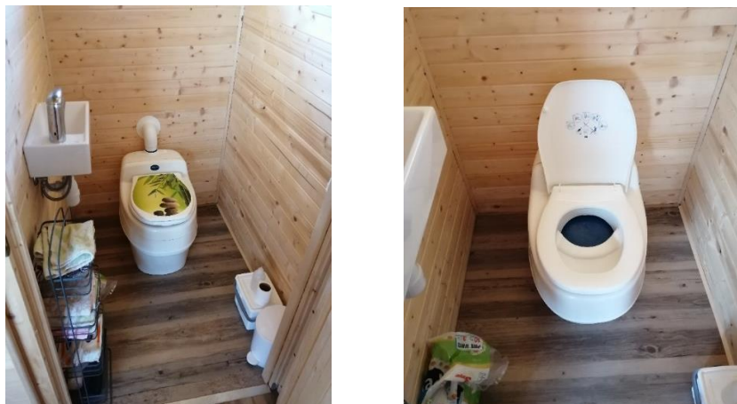
Slika 20: Kompostno stranišče Separera z ločevalnikom blata in urina 30
