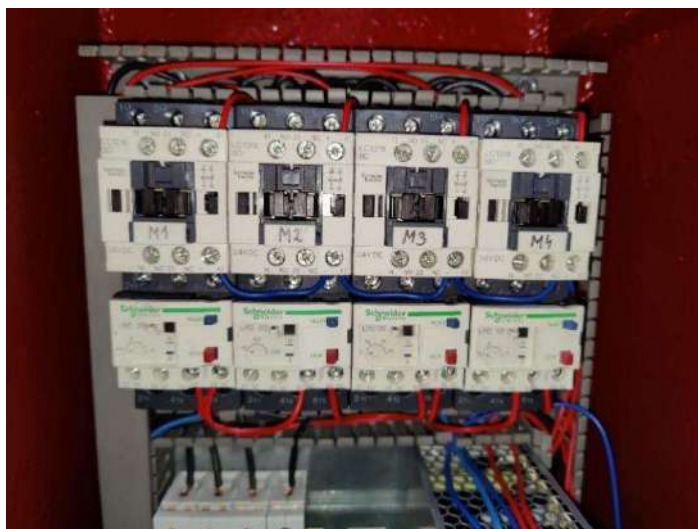
Slika 3: Kontaktorji (Osebni vir)
