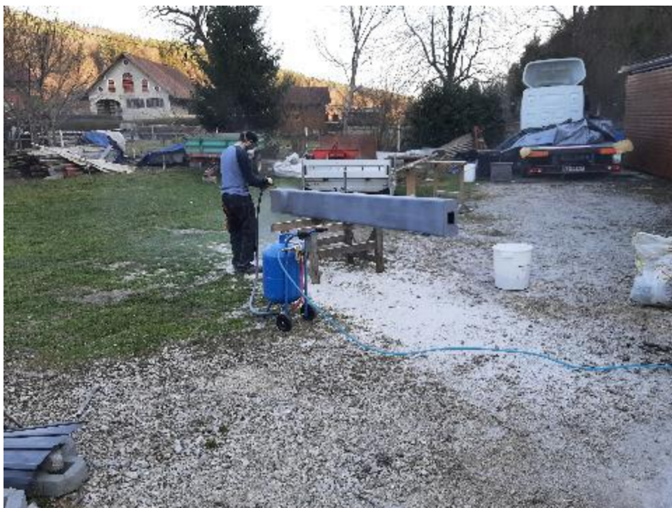
Slika 29: Prikaz postopka peskanja
