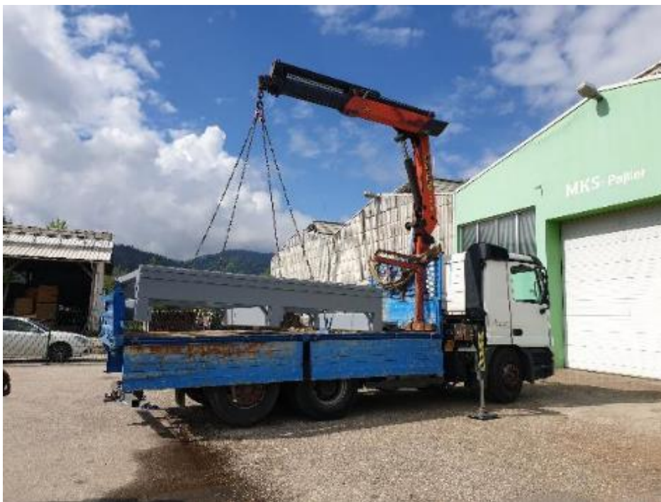
Slika 31: Konstrukcija v temeljni barvi
