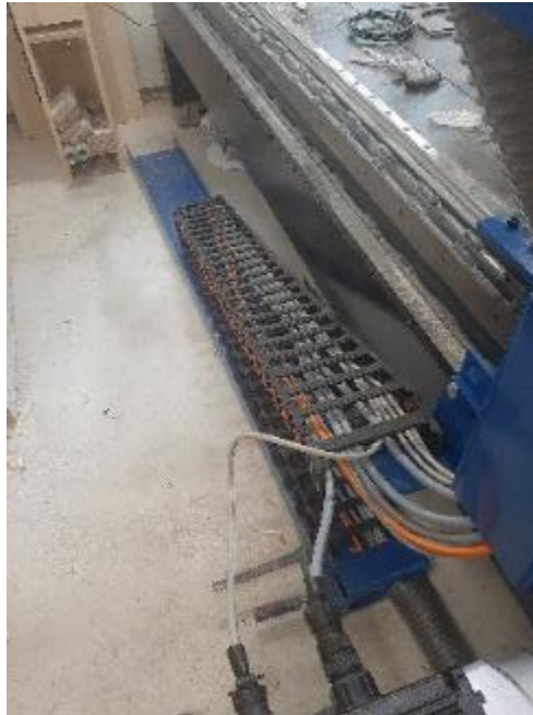
Slika 49: Montaža kanala in verige na y osi
