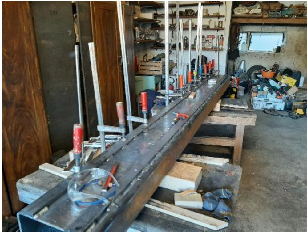
Slika 25: Varjenje jeklenega valjanca na konstrukcijo mostu
