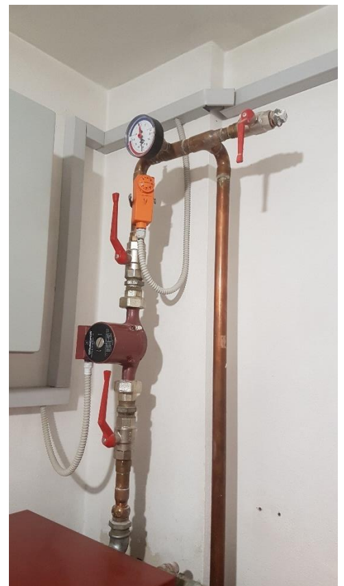
27 Ožičenje črpalk in termostatov
